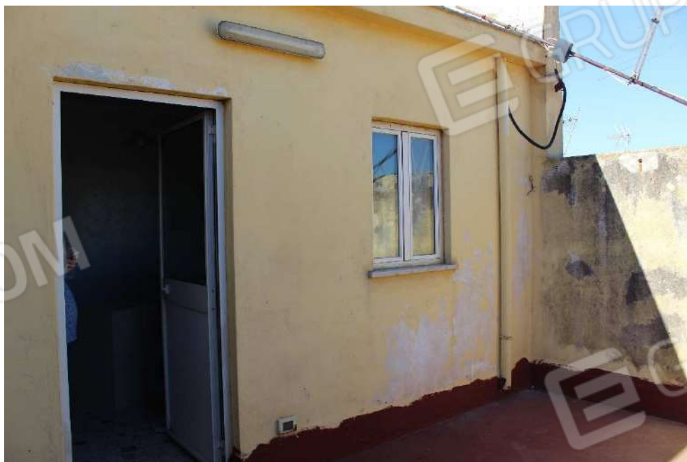
Foto n. 26 – Prospetto rientrato su Via Aguglia. (piano terzo).
