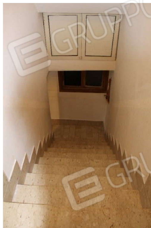
Foto nn. 13 – Vano scala, terza rampa.
