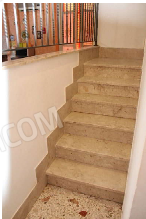
Foto n. 12 – Vano scala, seconda rampa.
