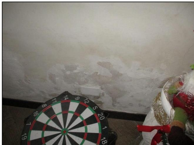
Foto 21 – tracce di umidità di risalita nel corridoio di disimpegno
