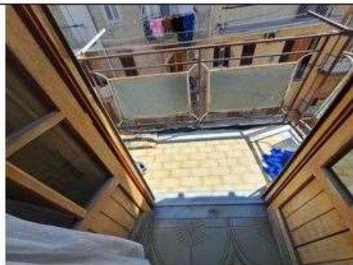
Foto n. 6 – Immobile sito in Palermo, Via G. Gentile n. 16 (di fatto civ. 14), piano 3° - Balcone lato Via G. Gentile
