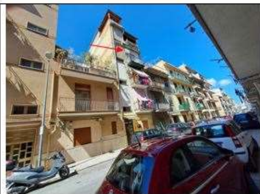
Foto n. 1 – Immobile sito in Palermo, Via G. Gentile n. 16 (di fatto civ. 14), piano 3° - Prospetto su Via G. Gentile
