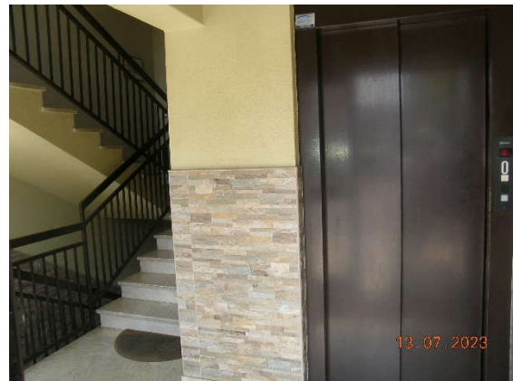
Foto 8 – Androne edificio H
