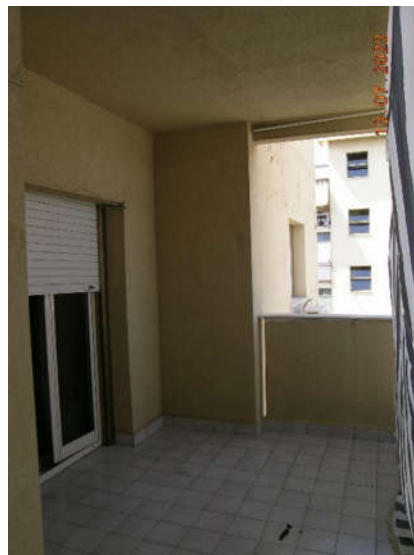
Foto 18 - Balcone su retrospetto
