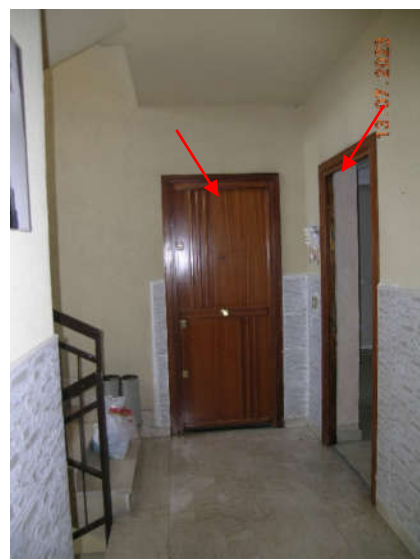
Foto 10 - Pianerottolo 4° piano – appartamento int.sx
