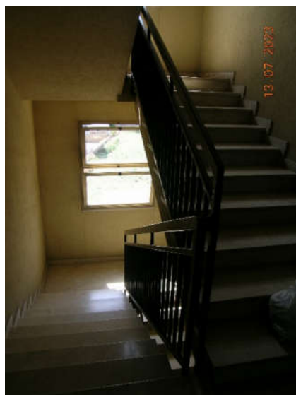
Foto 9 - Scala edificio H
