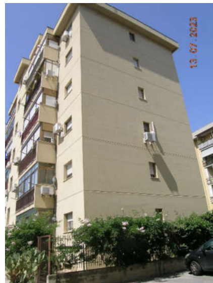
Foto 4 - Edificio H -fronte sud-ovest
