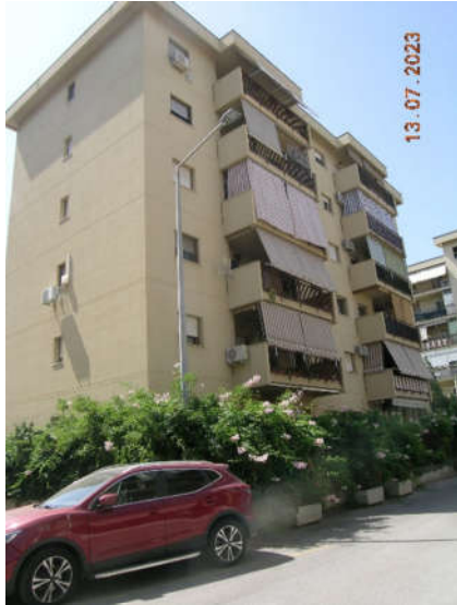
Foto 5 - Edificio H – Retrospetto fronte sud-est
