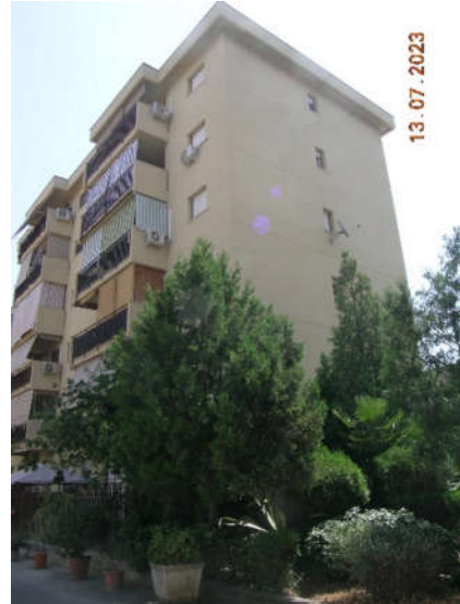
Foto 6 - Edificio H – fronte nord est
