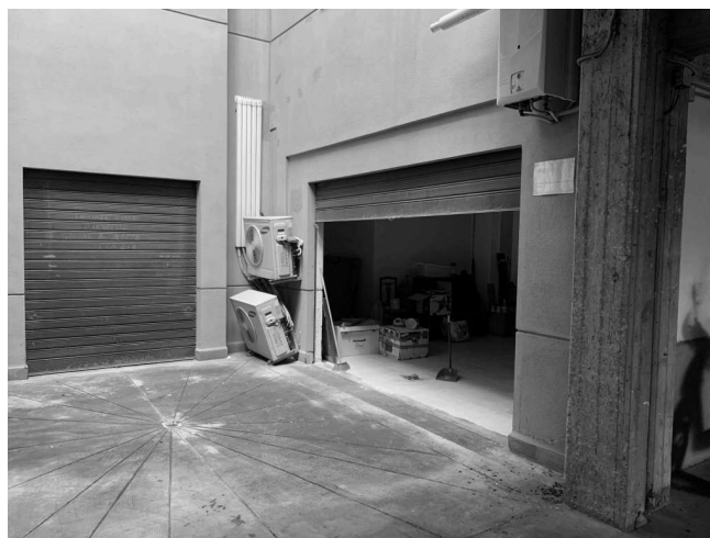
Foto n. 12 – Saracinesche di accesso all’immobile
