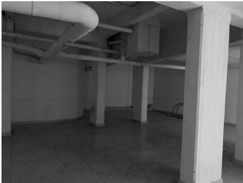
Foto n. 14 – Porzione di immobile terminale
