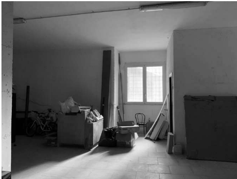
Foto n. 16 – Porzione di immobile dove sulla dx vi è l'accesso al wc
