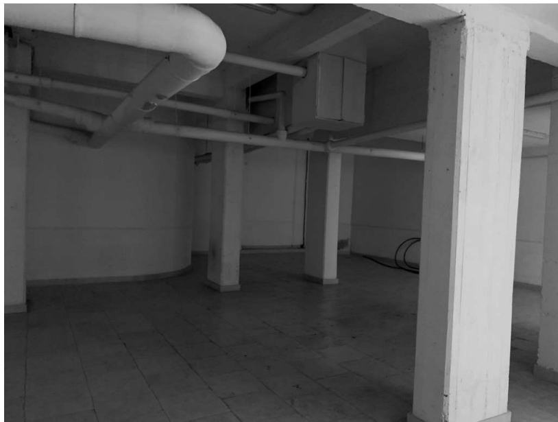
Foto n. 14 – Porzione di immobile terminale
