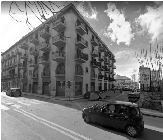
foto n. 09 – Edificio sito a Palermo tra C.so Alberto Amedeo e Via V. Ievolella
