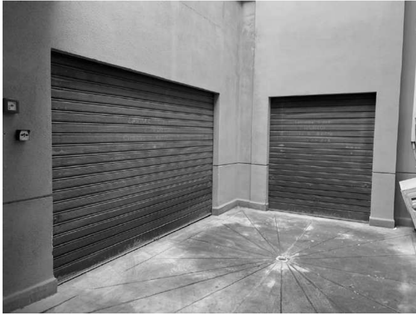
Foto n. 11 – Saracinesche di accesso all'immobile
