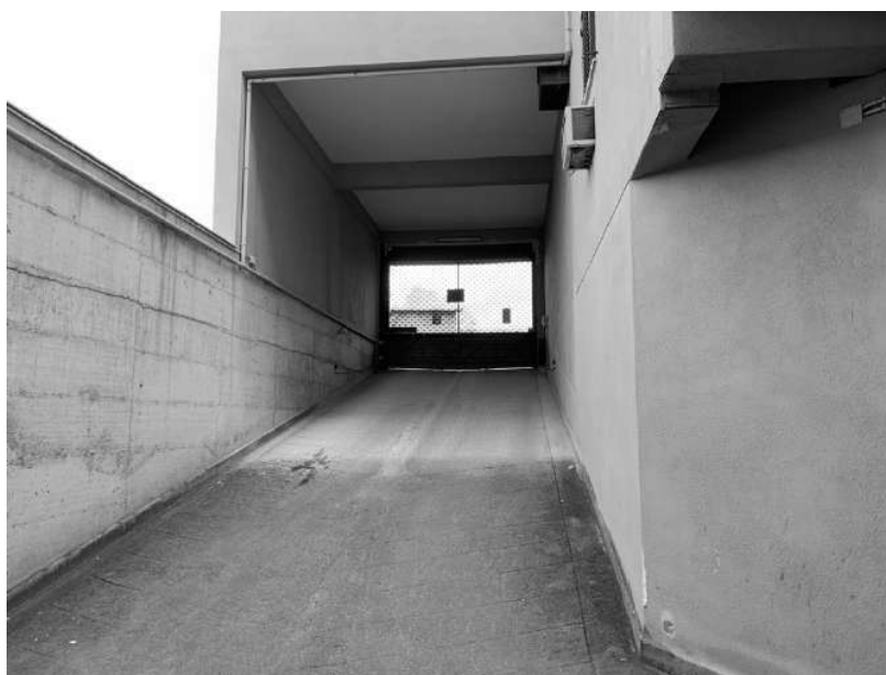
Foto n. 10 – Scivolo carrabile che conduce all'immobile
