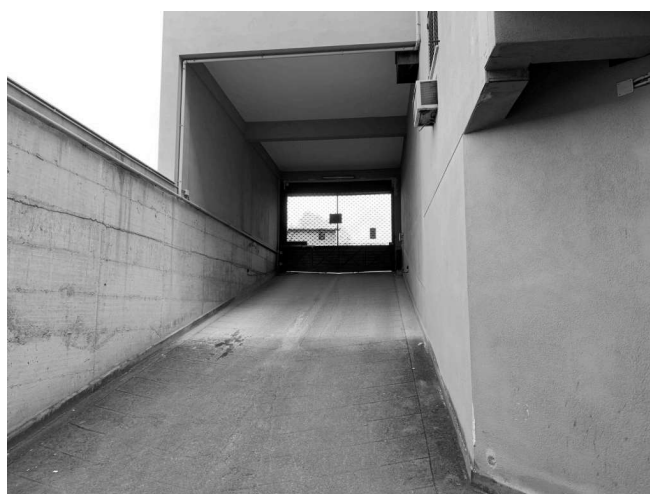
Foto n. 10 – Scivolo carrabile che conduce all'immobile
