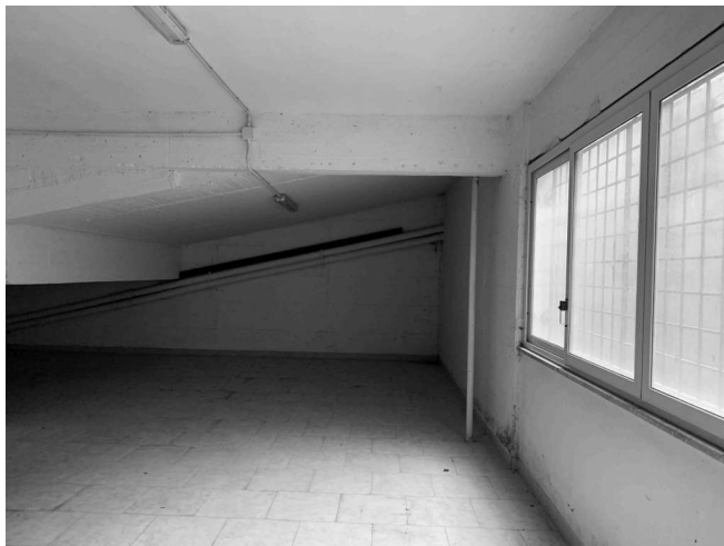
Foto n. 15 – Porzione di immobile corrispondente al sotto rampa di accesso
