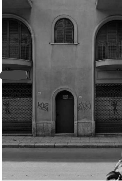
Foto n. 03 - Accesso all'immobile dal civ. n. 48/e di Corso Alberto Amedeo
