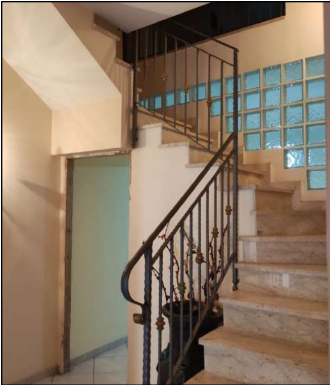
Scala interna di accesso al terzo piano
