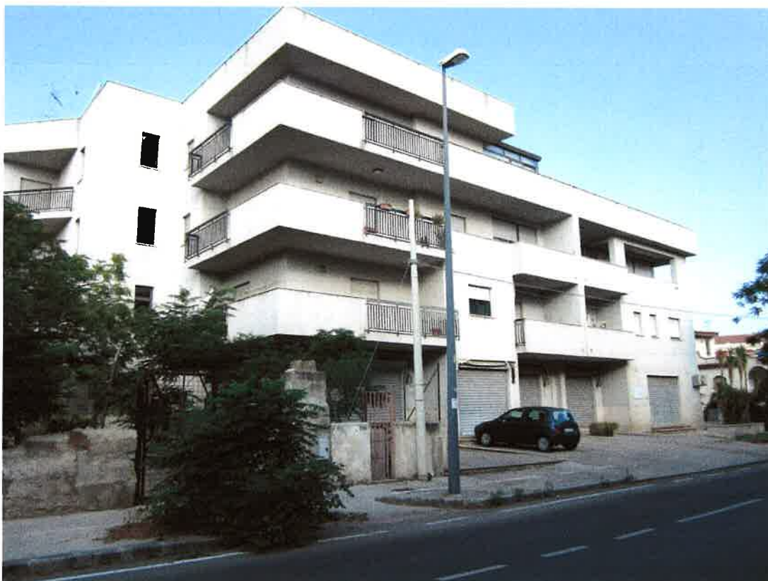
Foto 34: inquadratura dal Corso Baldassare Scaduto, dal punto di vista opposto rispetto alla foto precedente, dell'edificio identificato catastalmente, nel foglio 7 di Bagheria, dalla particella 1642; al piano strada le cinque serrande metalliche avvolgibili a protezione delle cinque luci del locale commerciale identificato catastalmente dalla particella 1642 sub. 44 che si aprono sul Corso Scaduto civv. 109/119
