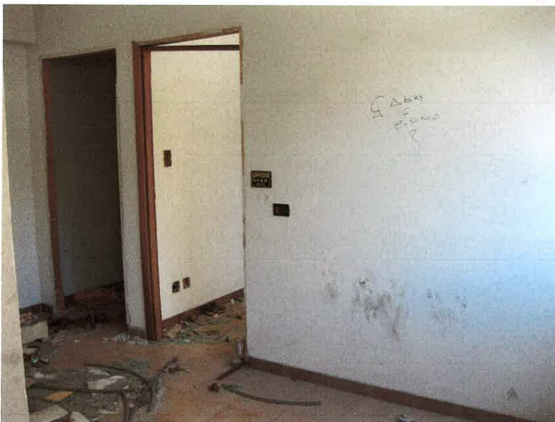
Foto 12: il vano d'ingresso all'unità immobiliare destinata ad ufficio, ubicata al primo piano, identificata, nel foglio 12 di Bagheria, dalla particella 959 sub. 9
