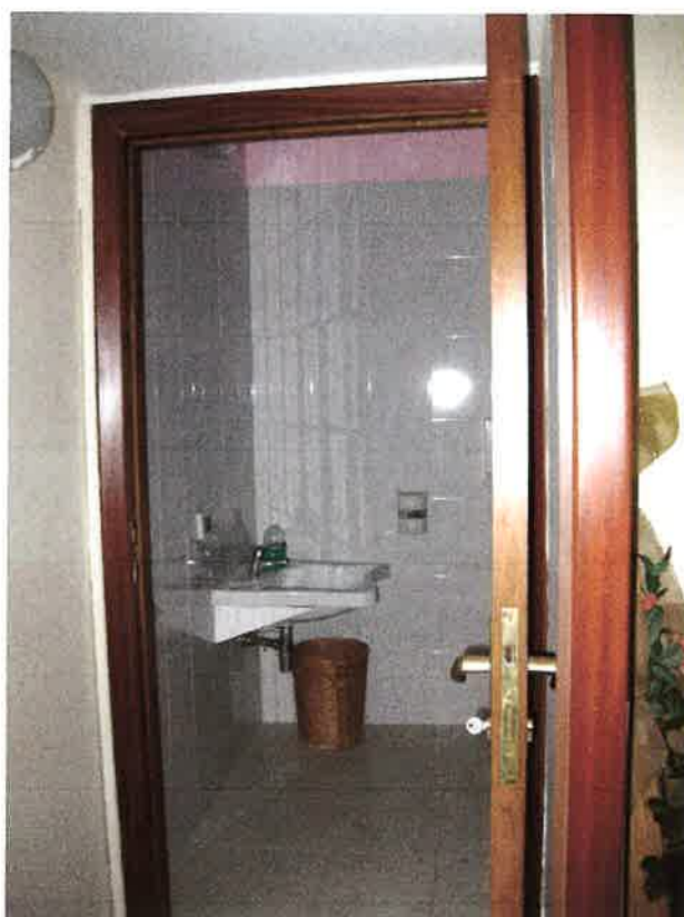
Foto 39: il w.c. a servizio della porzione del locale commerciale, indicata catastalmente come "retrobottega"
