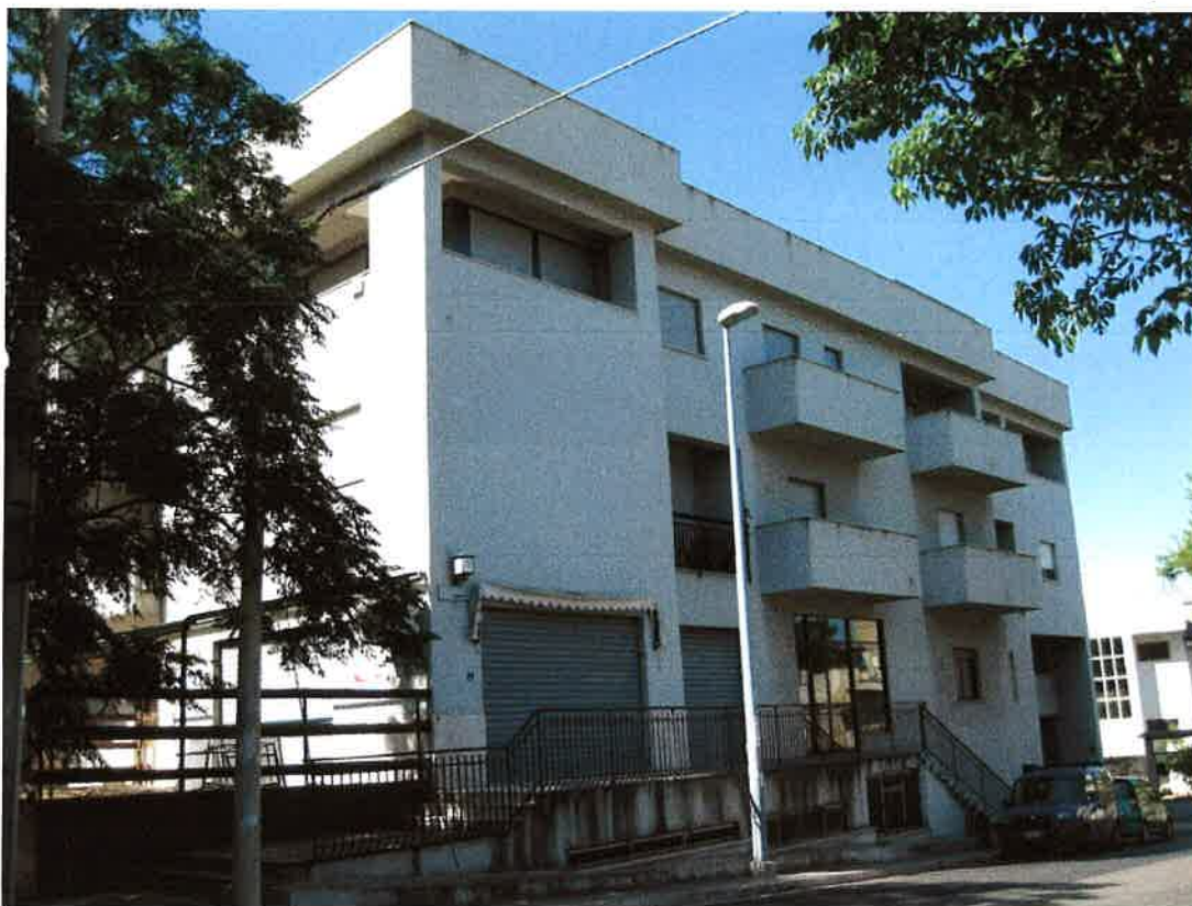
Foto 47: il prospetto laterale dell'edificio identificato catastalmente, nel foglio 7 di Bagheria, dalla particella 1642 che si affaccia sulla Via Amalfi, dalla quale si diparte la rampa che conduce al piano scantinato
