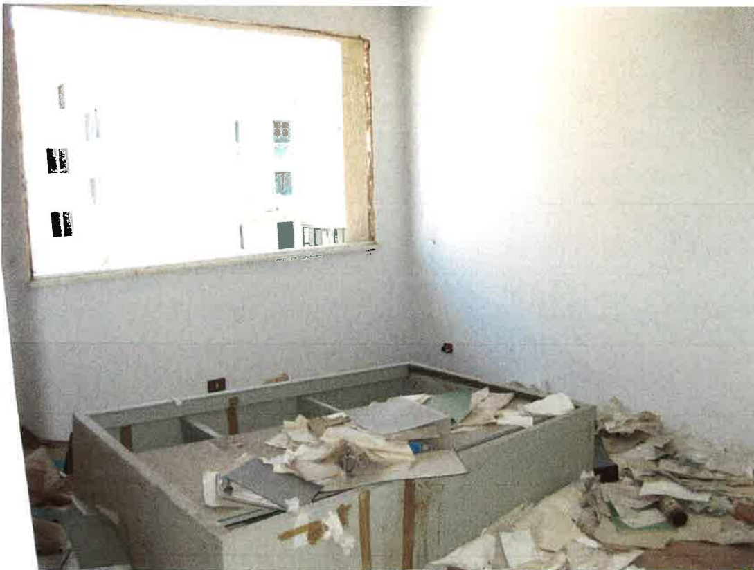
Foto 18: il primo ambiente dell'unità immobiliare destinata ad ufficio, identificata, nel foglio 12 di Bagheria, dalla particella 959 sub. 11, con affaccio sulla Via Teocrito
