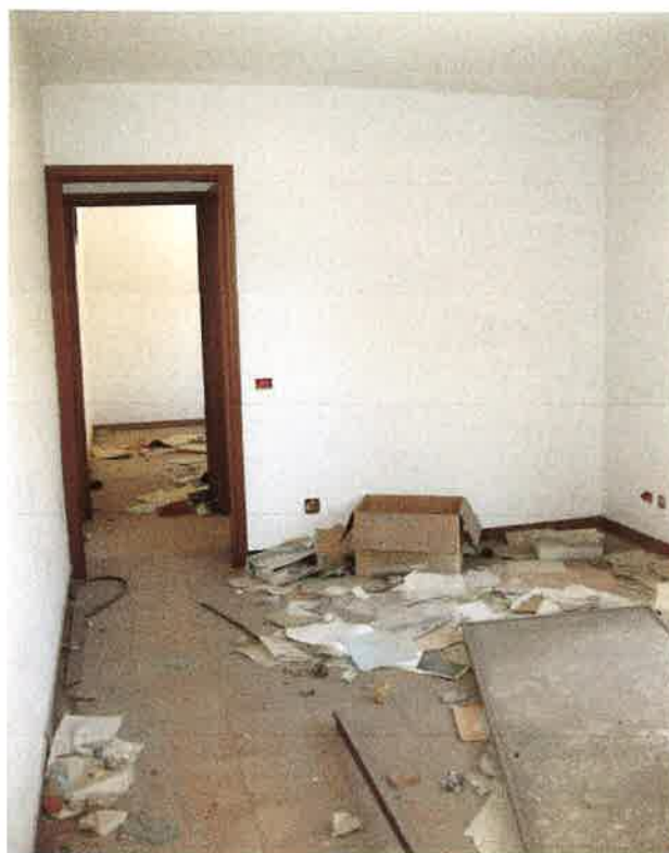
Foto 13: il primo ambiente dell'unità immobiliare destinata ad ufficio, ubicata al primo piano, identificata, nel foglio 12 di Bagheria, dalla particella 959 sub. 9, con affaccio sulla via Teocrito
