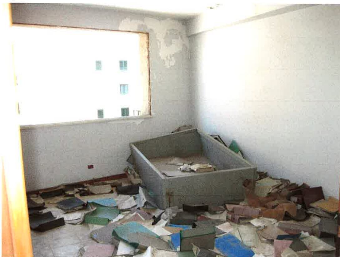
Foto 20: il secondo ambiente dell'unità immobiliare destinata ad ufficio, identificata, nel foglio 12 di Bagheria, dalla particella 959 sub. 11, con affaccio sulla Via Teocrito
