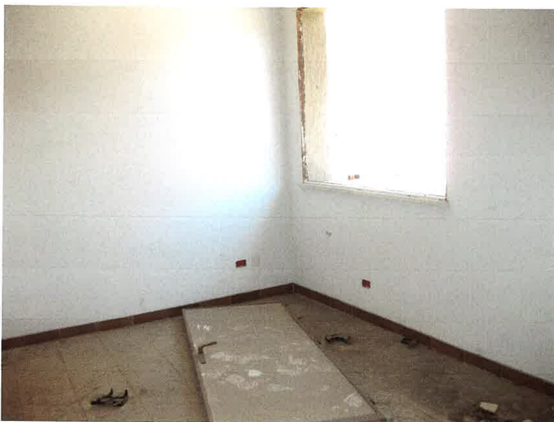
Foto 25: il secondo ambiente dell'unità immobiliare destinata ad ufficio, identificata, nel foglio 12 di Bagheria, dalla particella 959 sub. 13, con affaccio sulla Via Teocrito
