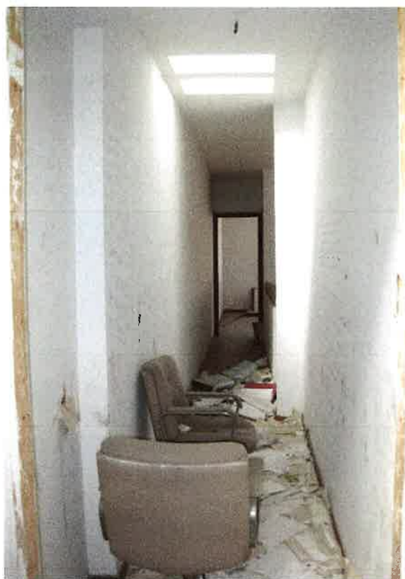
Foto 26: il corridoio condominiale, del secondo piano, che conduce all'unità immobiliare destinata ad ufficio, identificata, nel foglio 12 di Bagheria, dalla particella 959 sub. 14
