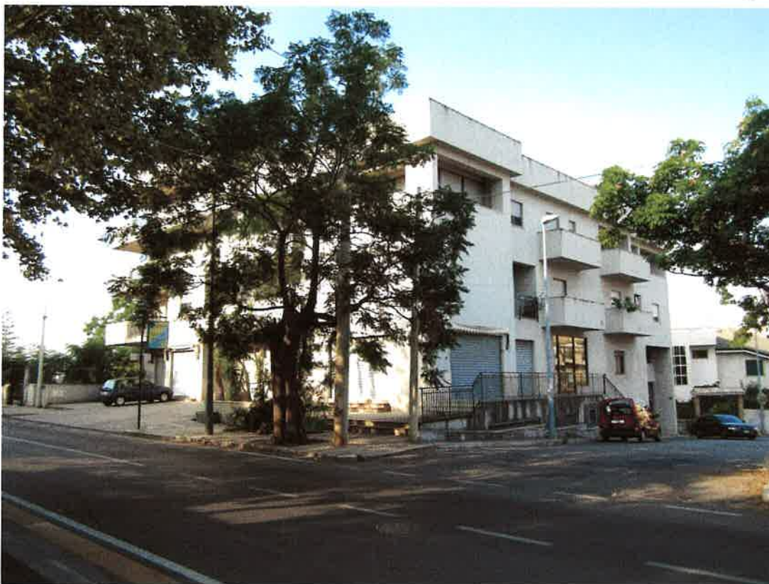
Foto 33: vista, dal Corso Baldassare Scaduto, dell'edificio identificato catastalmente, nel foglio 7 di Bagheria, dalla particella 1642
