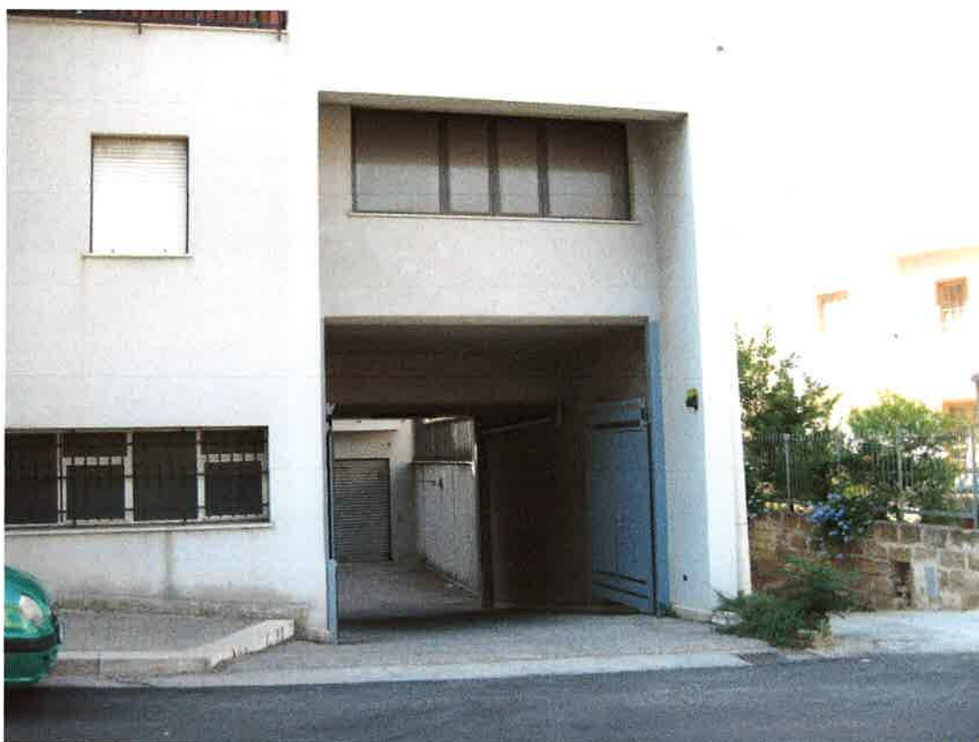
Foto 48: la rampa che dalla Via Amalfi conduce al piano scantinato dell'edificio identificato catastalmente, nel foglio 7 di Bagheria, dalla particella 1642
