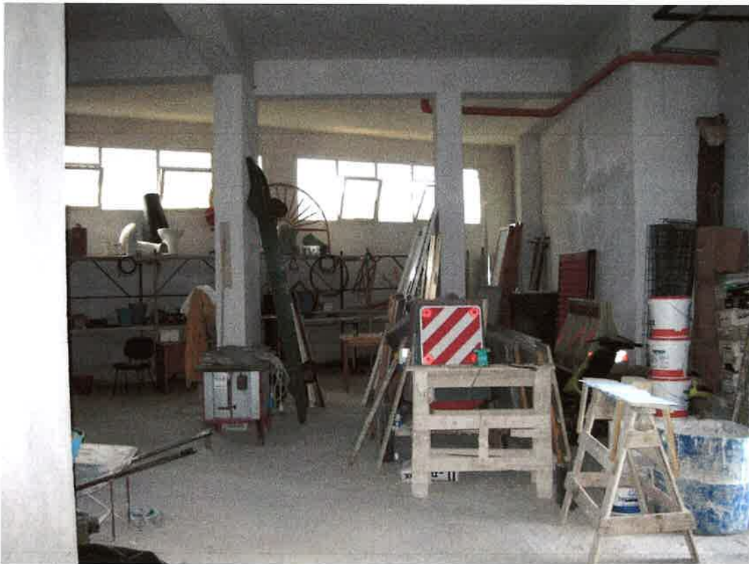
Foto 49: il locale box identificato, nel foglio 7 di Bagheria, dalla particella 1642 sub. 39; in difformità a quanto rappresentato catastalmente, manca la muratura di separazione dal limitrofo locale identificato dalla particella 1642 sub. 40
