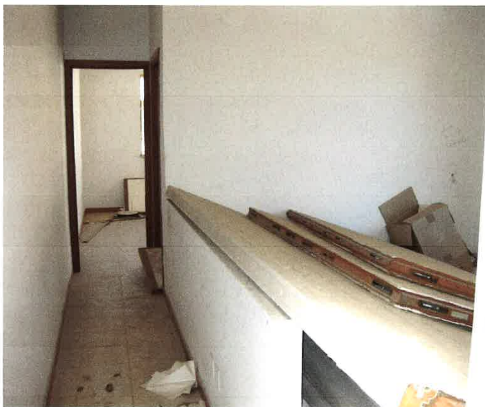
Foto 27: il primo ambiente dell'unità immobiliare al secondo piano, destinata ad ufficio, identificata, nel foglio 12 di Bagheria, dalla particella 959 sub. 14, con affaccio sulla Via Teocrito
