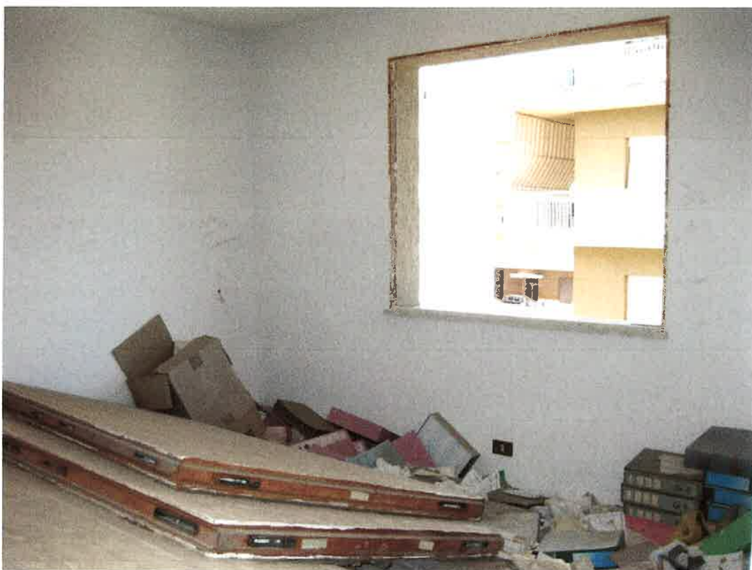
Foto 28: altra inquadratura del primo ambiente dell'unità immobiliare al secondo piano, destinata ad ufficio, identificata, nel foglio 12 di Bagheria, dalla particella 959 sub. 14, con affaccio sulla Via Teocrito
