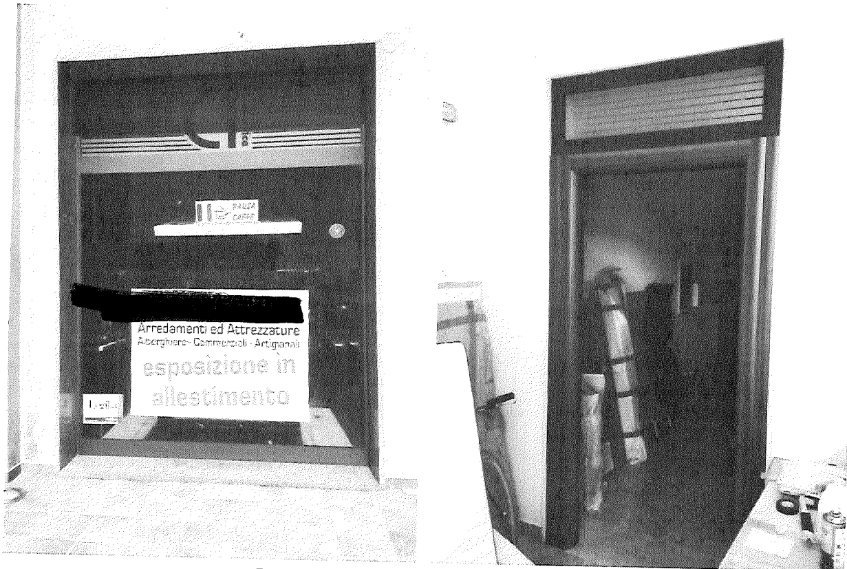
Foto 3 e 4 – infisso esterno e porta interna
