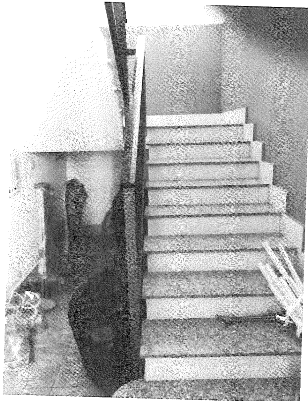
Foto 10 – vano scala di collegamento tra piano terra e piano primo
