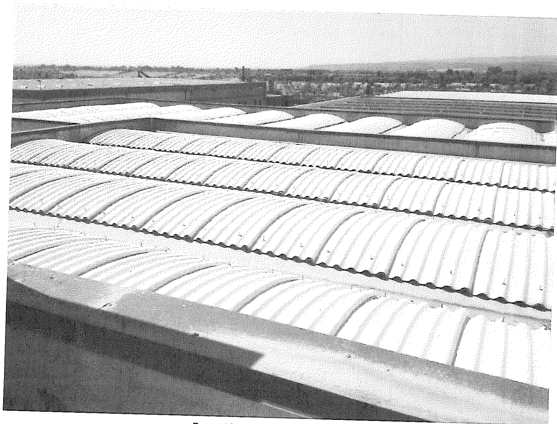
Foto 17 – copertura corpo B
