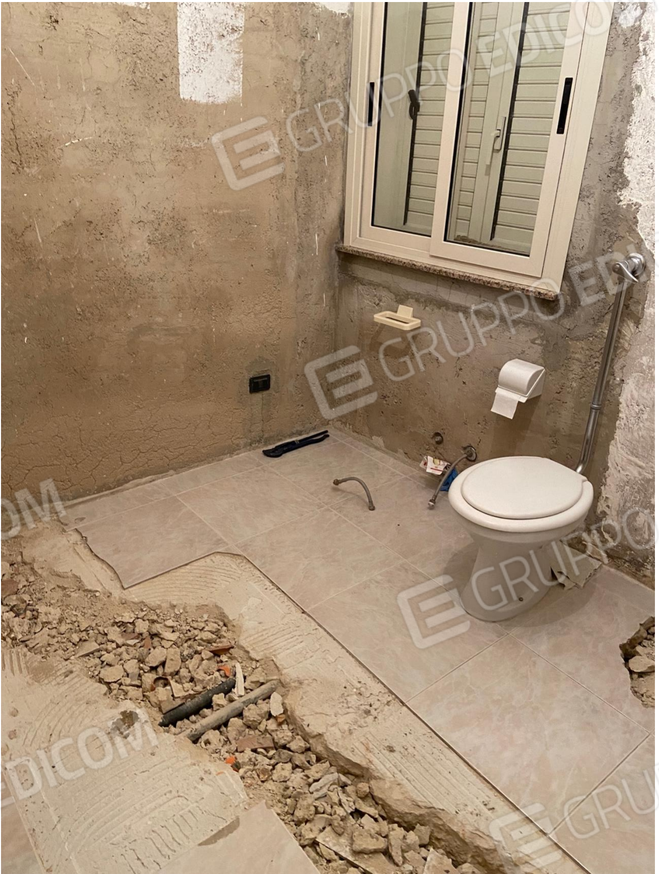
Figura 4- BAGNO PIANO TERRA
