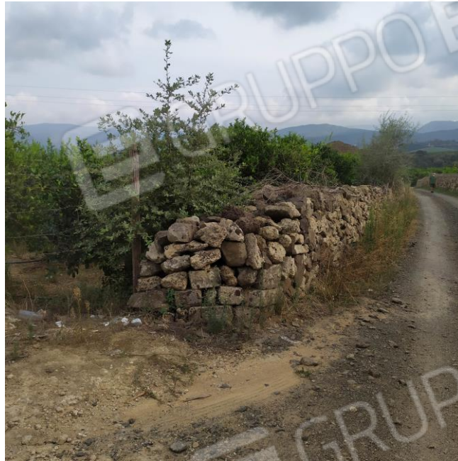
Contrada Piano Lepre – lotto foglio n. 44 particella n. 50
