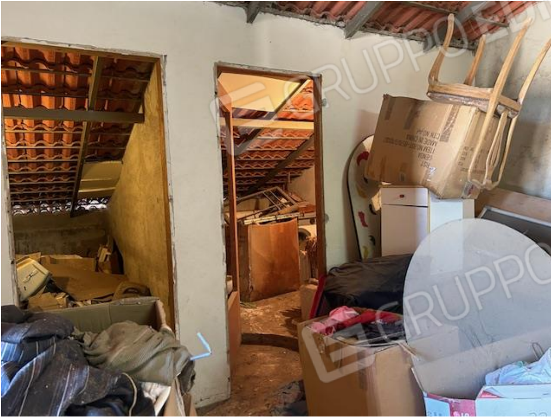
VISTE 12-13-14_Interni Locali sgombero 2°P
