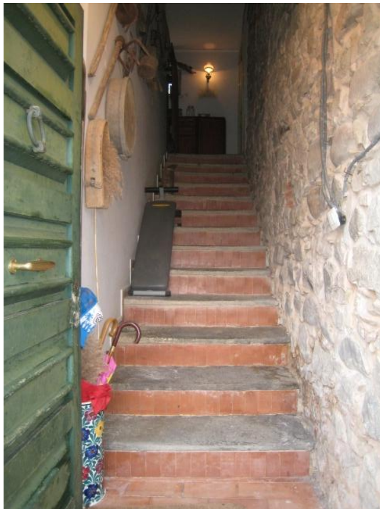
Foto n. 32. La scala di accesso al primo piano.
