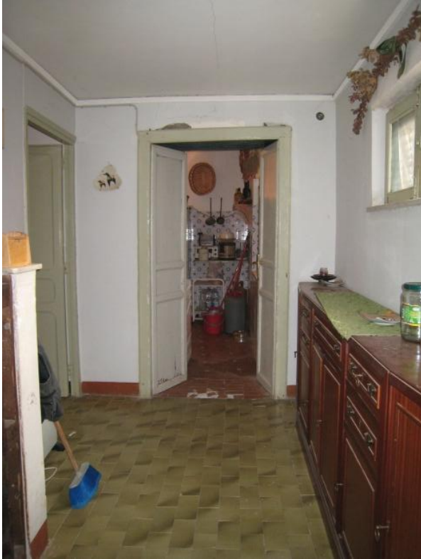
Foto n. 33. Il disimpegno di piano primo. In fondo la cucina.
