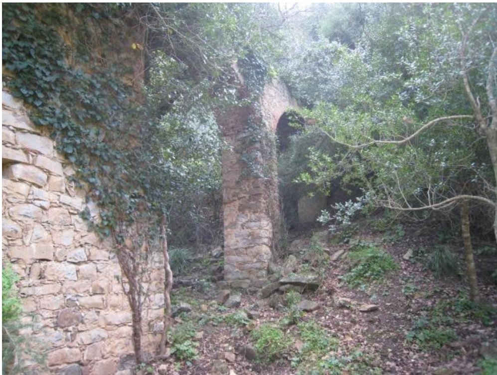
Foto n. 85. Le arcate che sorreggevano la condotta idrica.
