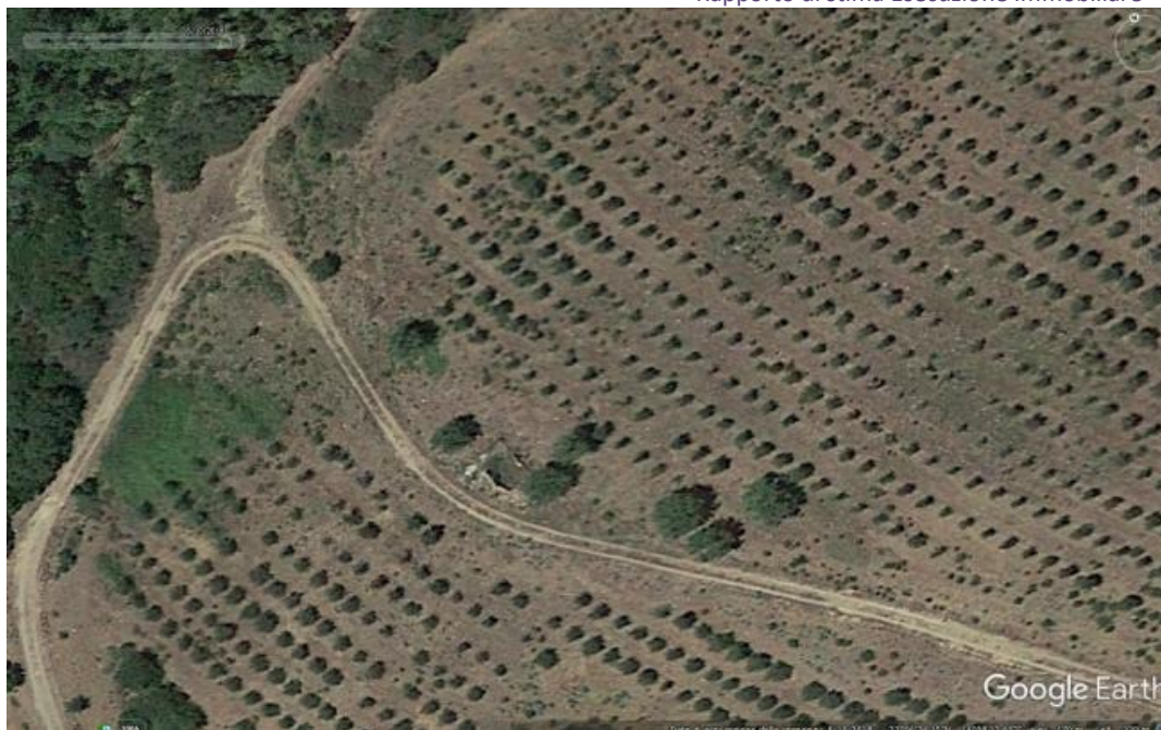
Foto n. 87. Di questa casa, detta casa Pagliera, rimane in piedi un solo setto murario.
