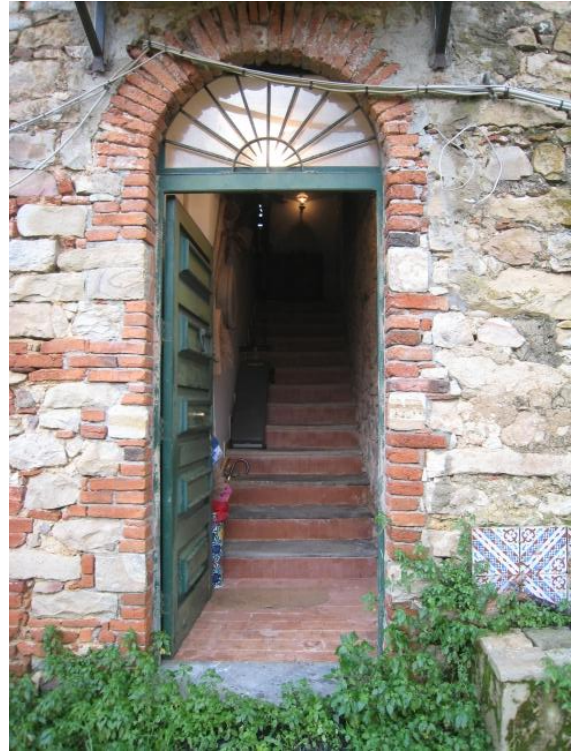
Foto n. 31. Il portone di ingresso all'unità di piano primo, corpo "B".
