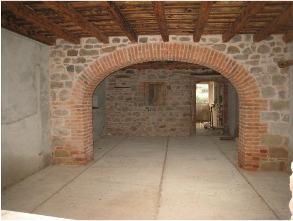
Foto n. 13. Magazzino al P.T. del corpo "B", prima stanza.
