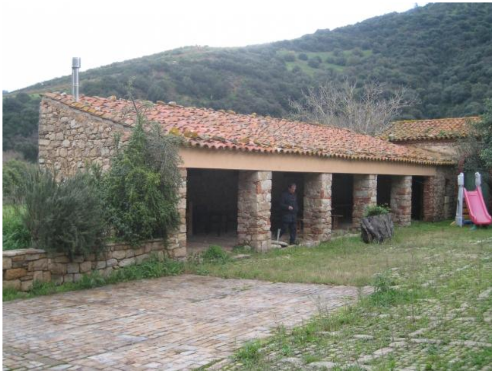
Foto n. 52. Porticato, corpo "D".
