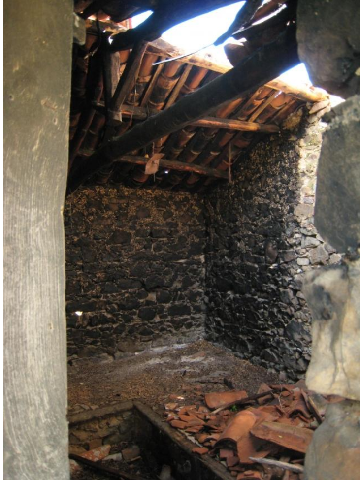
Foto n. 74. Interni del fabbricato ad un solo piano.
