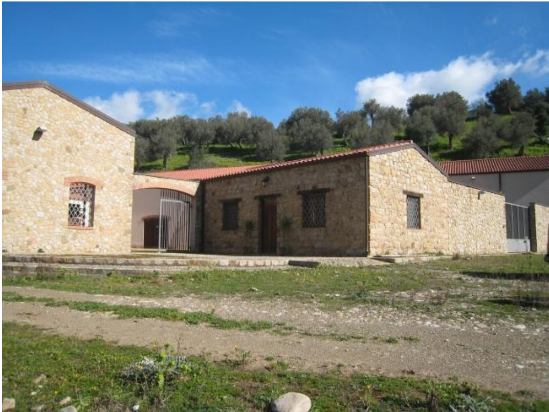
Foto n. 97. I due cancelli di ingresso con, al centro, l'ufficio ex F.R.
