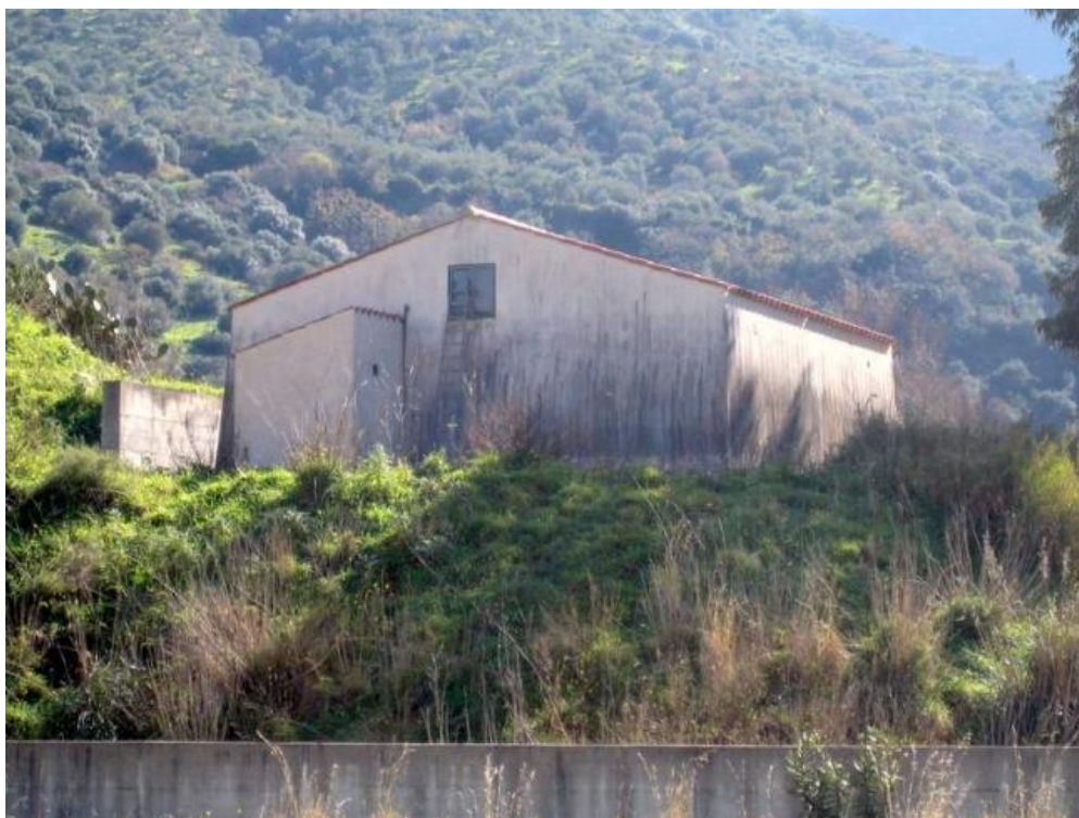
Fondo agricolo - La vasca in muratura chiusa con un tetto a due falde.
