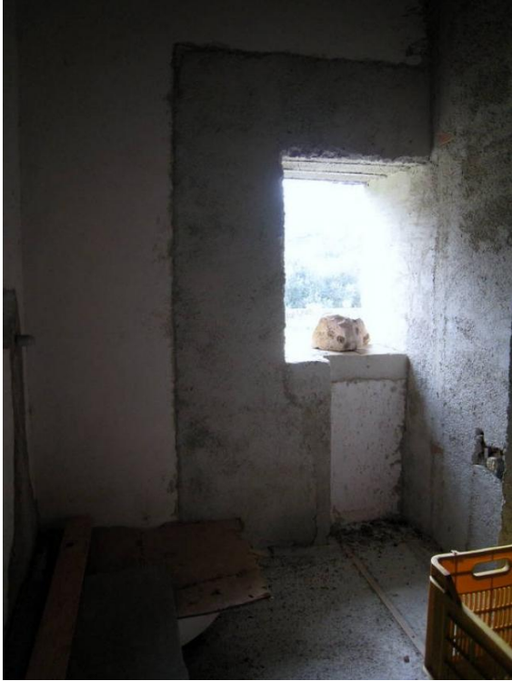
Foto n. 23. Uno dei due w.c. in fase di restauro.
