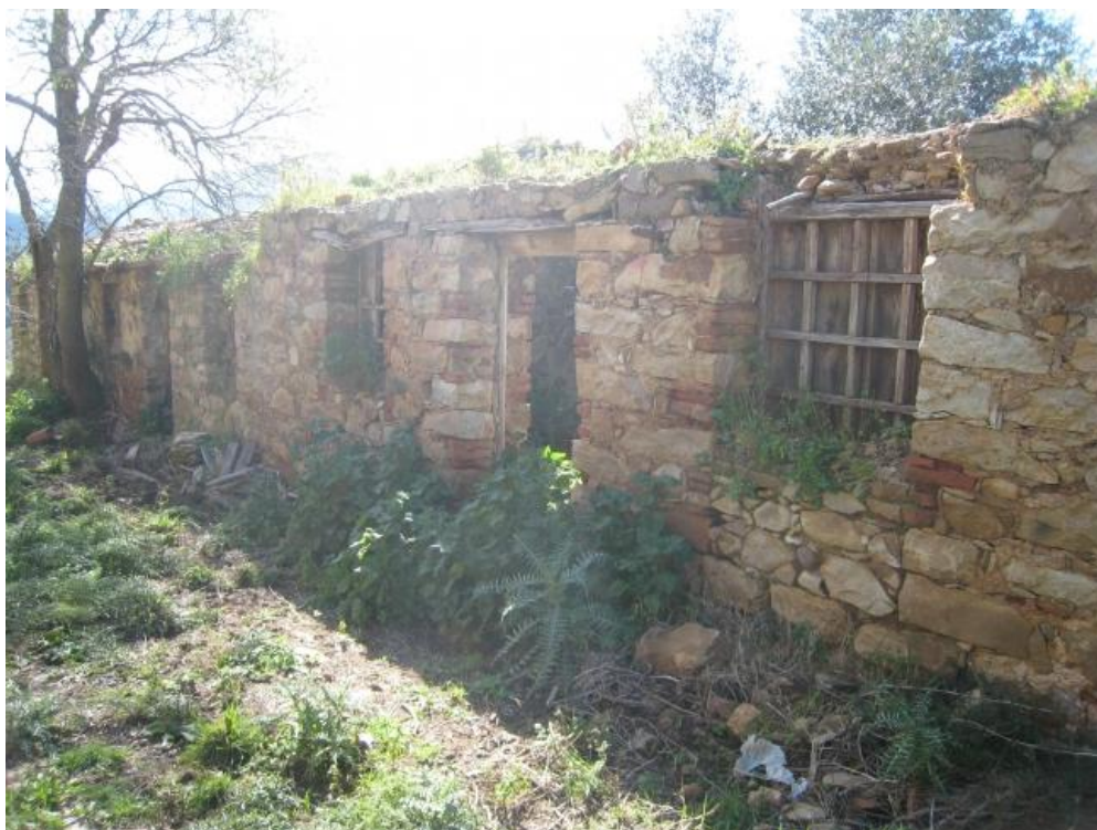
Foto n. 73. Altra immagine del prospetto principale del fabbricato ad una sola elevazione.
