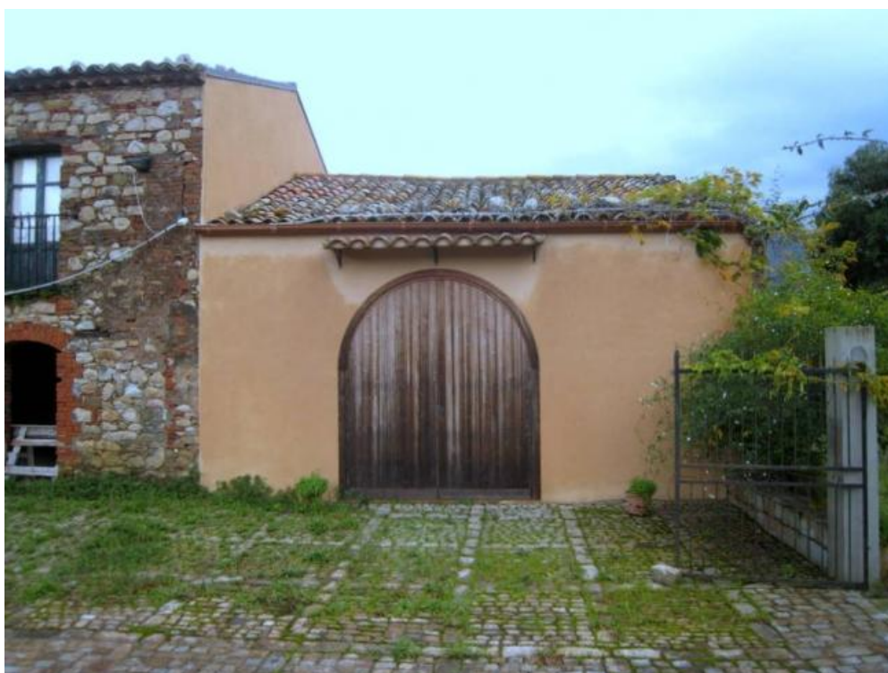
Foto n. 10. Il magazzino "A".
