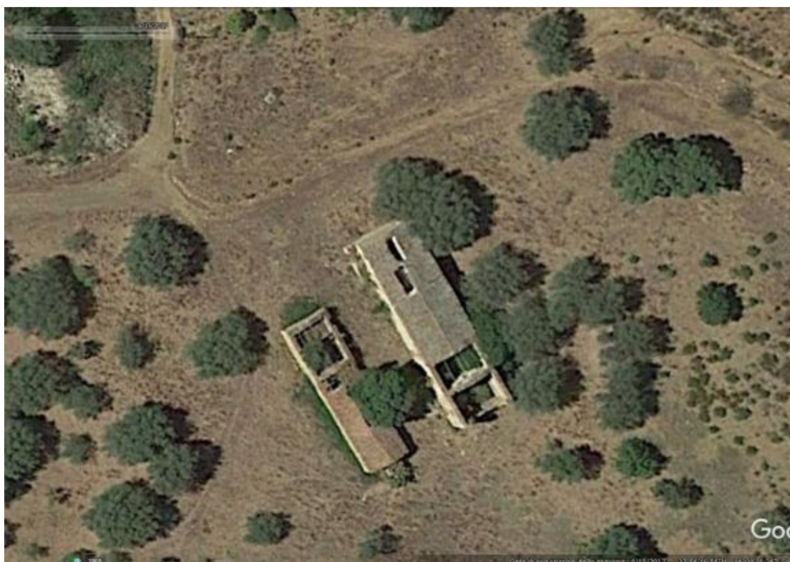
Foto n. 66. Le case Mocchiario. Sono evidenti le condizioni dei tetti che sono in parte mancanti.
