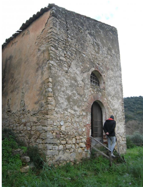
Foto n. 61. La chiesa, prospetto principale.
