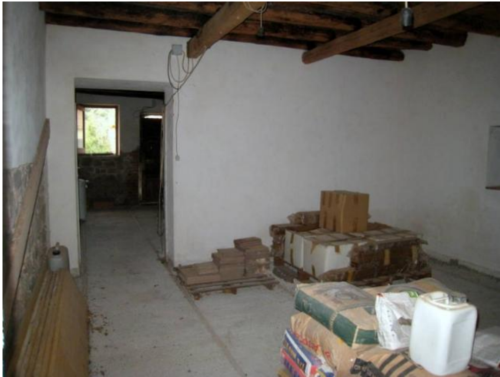
Foto n. 19. Locali al P.T. del corpo "B" in fase di ristrutturazione interna.
