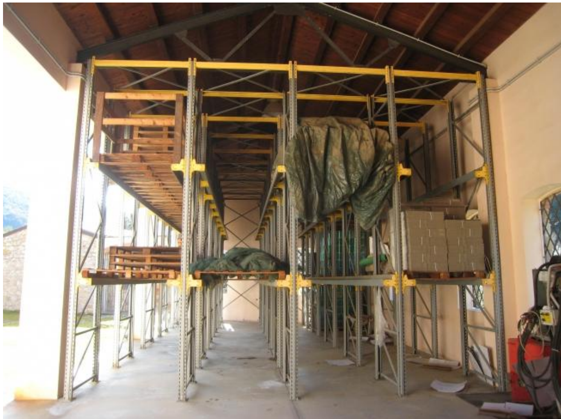
Foto n. 104. L'interno del portico.
