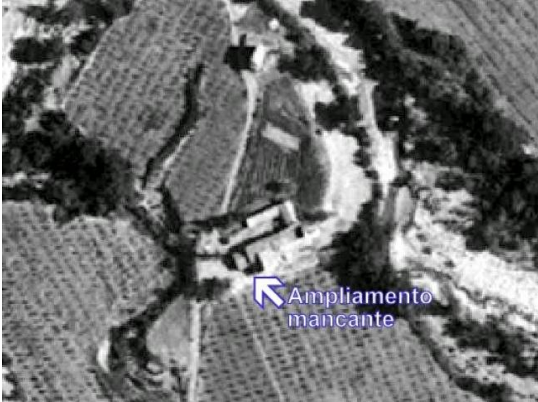
Baglio Tornisia - Foto aerea del 1994. L'ampliamento non era presente.
