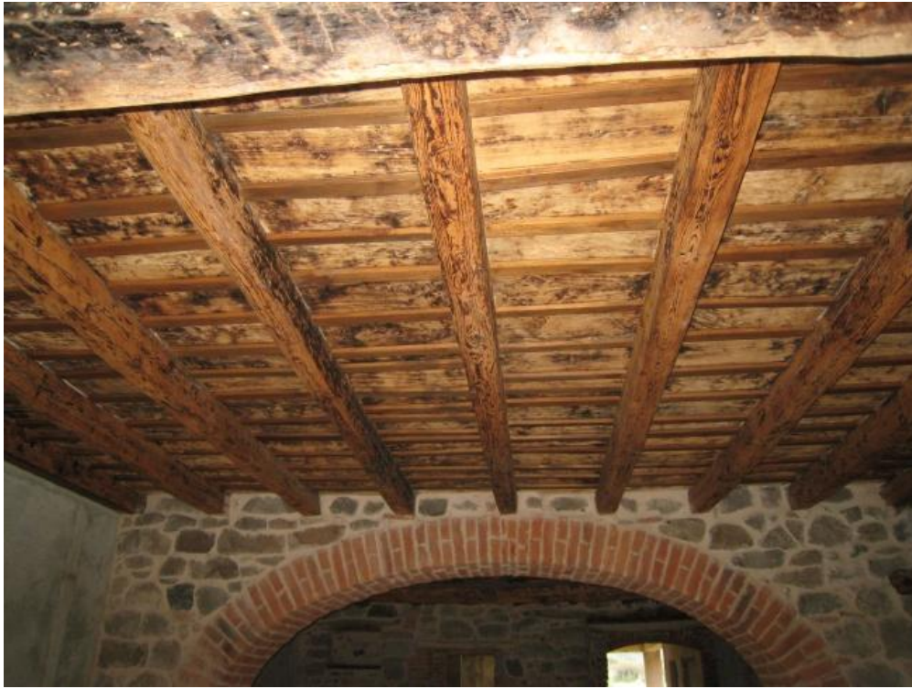
Foto n. 15. Dettaglio del solaio.
