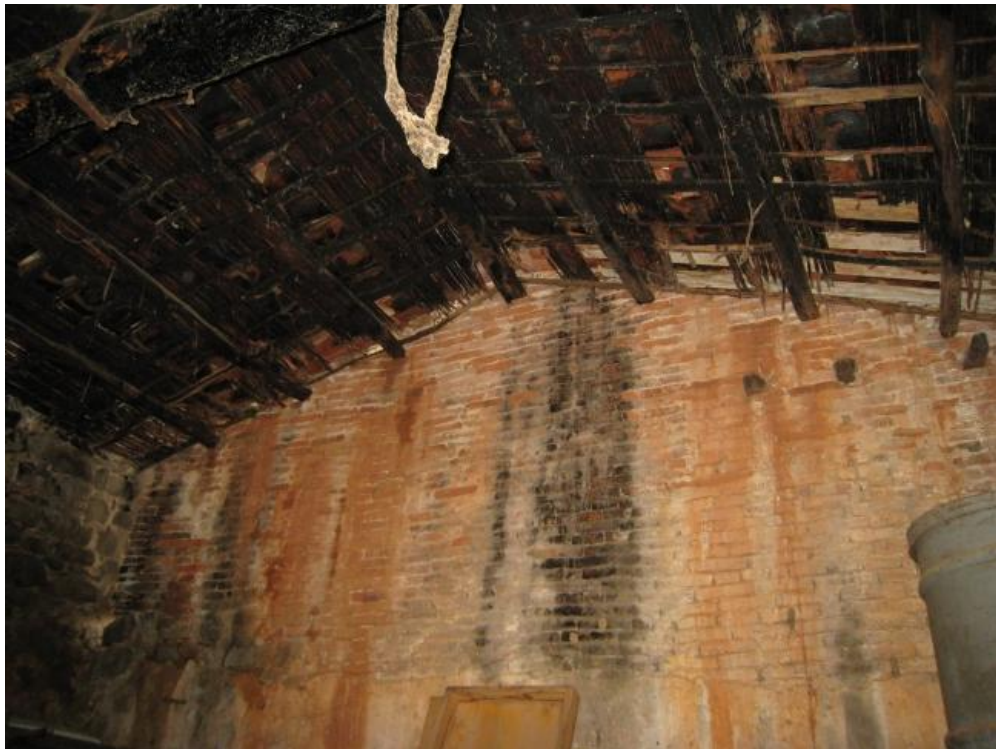
Foto n. 59. Altra immagine di pareti e tetto.
