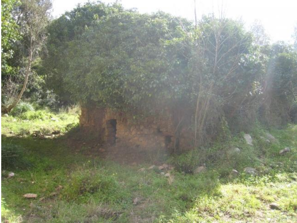
Foto n. 80. L'edificio più piccolo.
