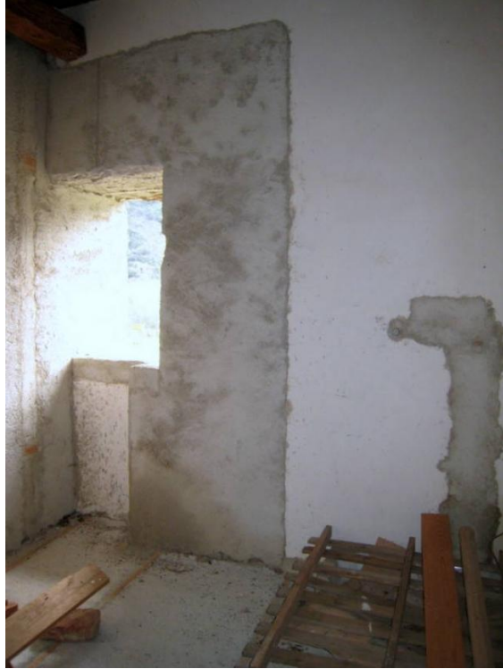
Foto n. 24. L'altro w.c. ancora al grezzo.
