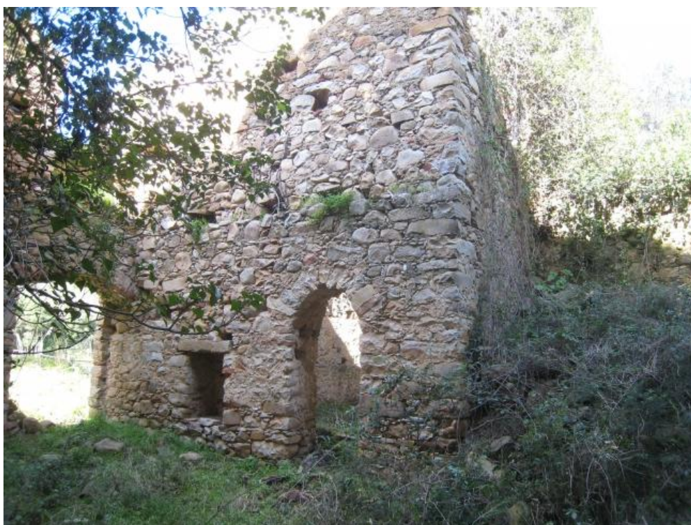
Foto n. 77. Altro prospetto dell'edificio più grande.
