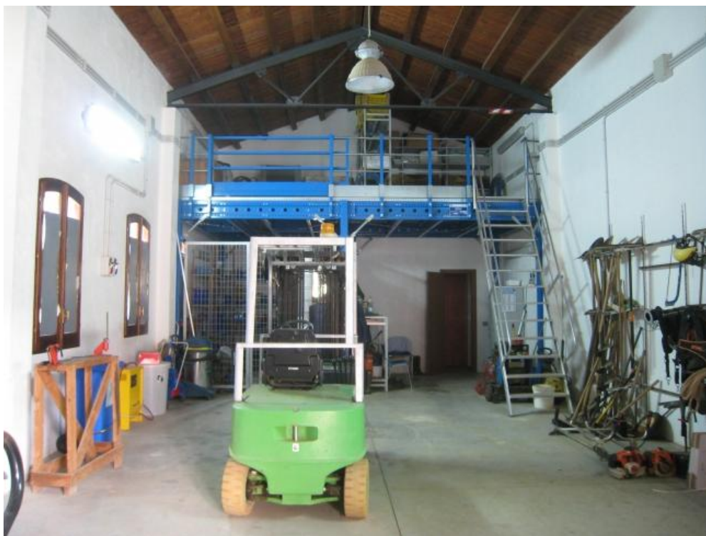
Foto n. 105. L'officina e deposito attrezzi. Il soppalco è del tipo smontabile e reversibile.
