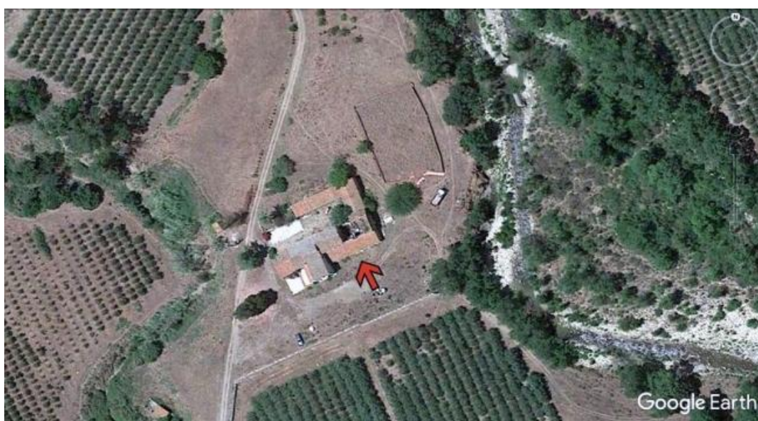
Foto n. 3. Ingrandimento del fabbricato oggetto di esecuzione.
