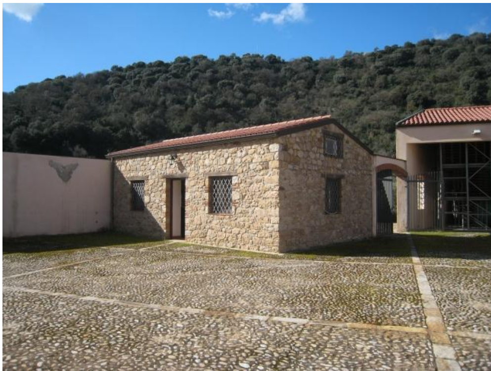
Foto n. 101. Dettaglio del fabbricato adibito ad ufficio.
