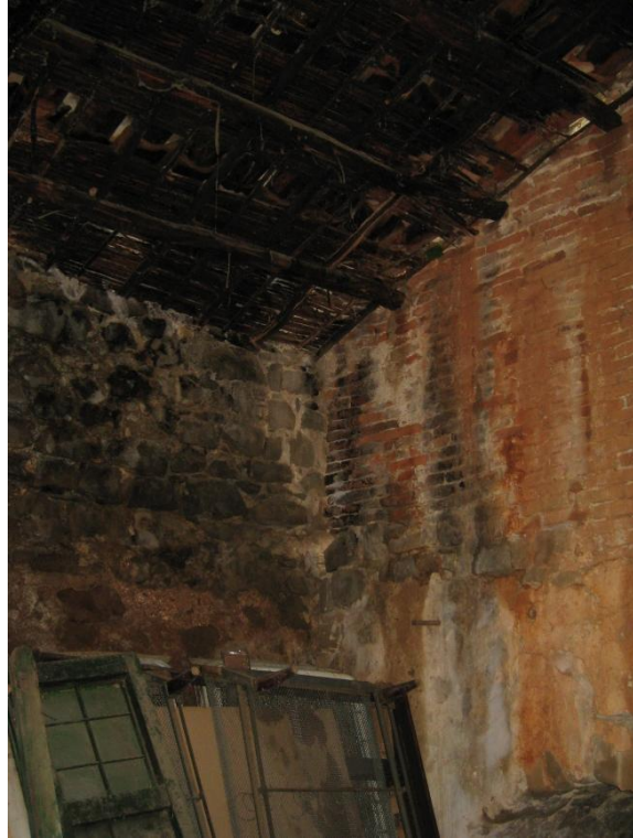
Foto n. 58. Pareti interne dei magazzini corpo "C".
