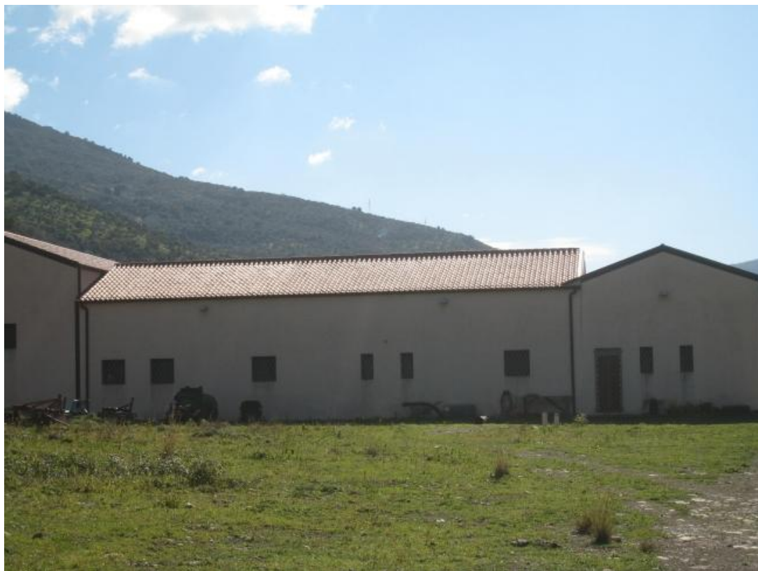
Foto n. 100. Prospetto opposto a quello della foto n. 90.
