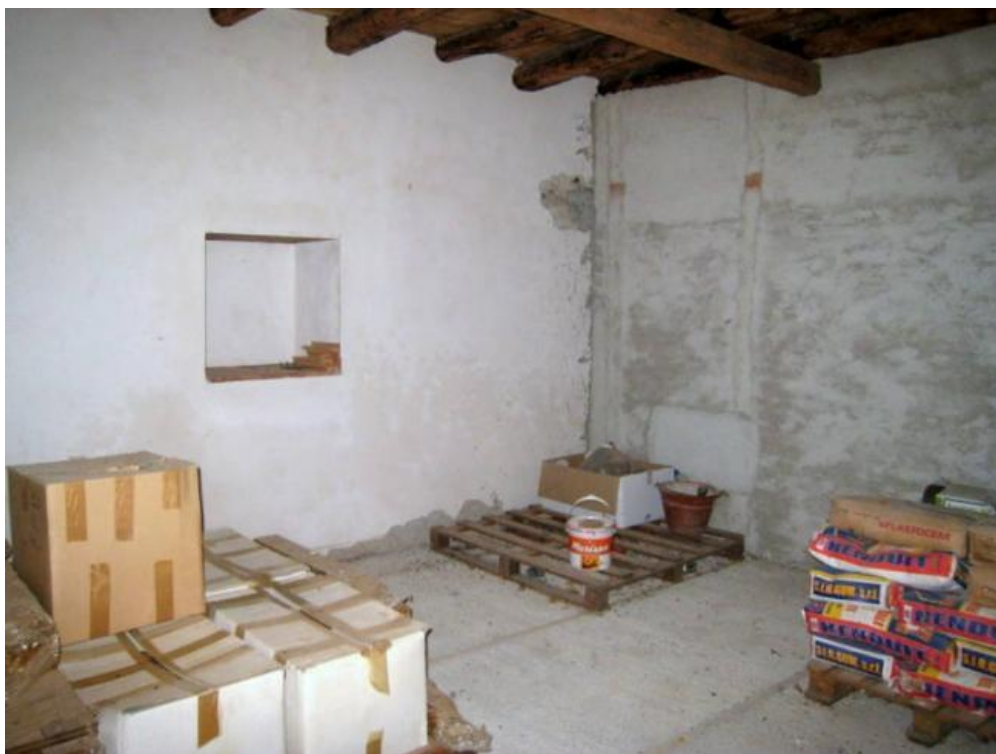
Foto n. 20. Locali in ristrutturazione.
