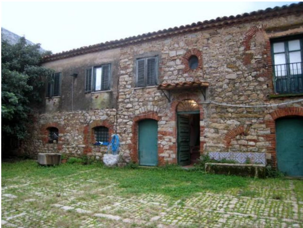
Foto n. 6. Altra immagine del corpo "B".
