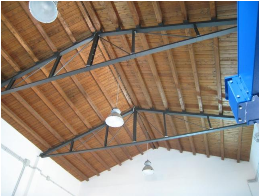
Foto n. 113. Copertura del frantoio.
