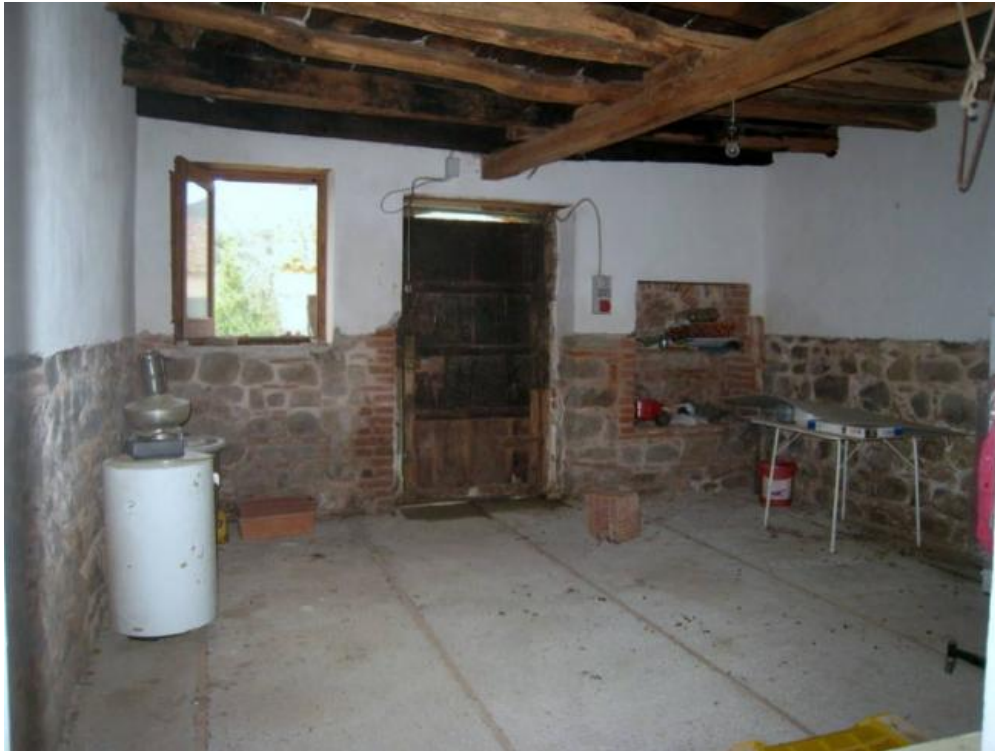
Foto n. 21. Altra stanza in fase di recupero.
