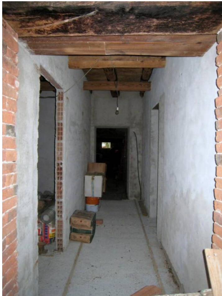
Foto n. 18. Corridoio al P.T. del corpo "B" che conduce anche alla stalla.
