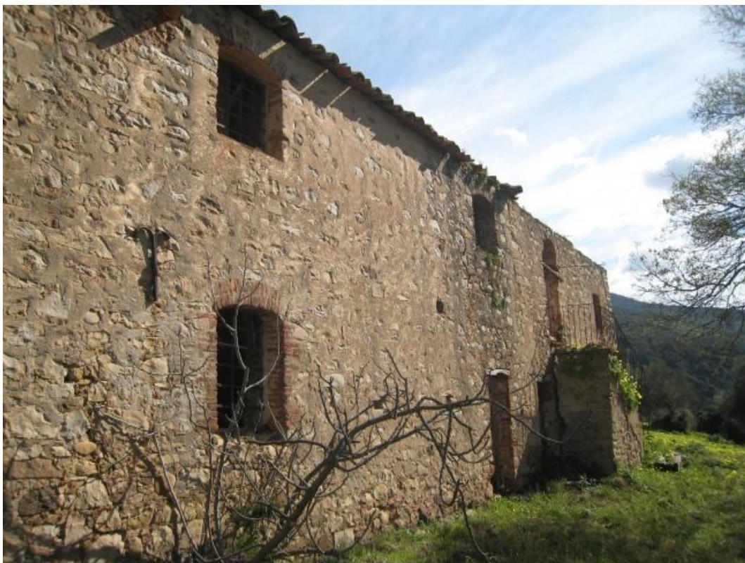
Foto n. 68. Prospetto principale dell'edificio a due piani.
