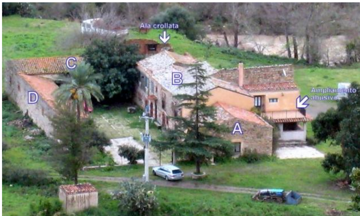
Baglio Tornisia - Foto del baglio Tornisia con indicati i diversi corpi che lo compongono. E' segnalata l'ala crollata e la parte costruita abusivamente.
