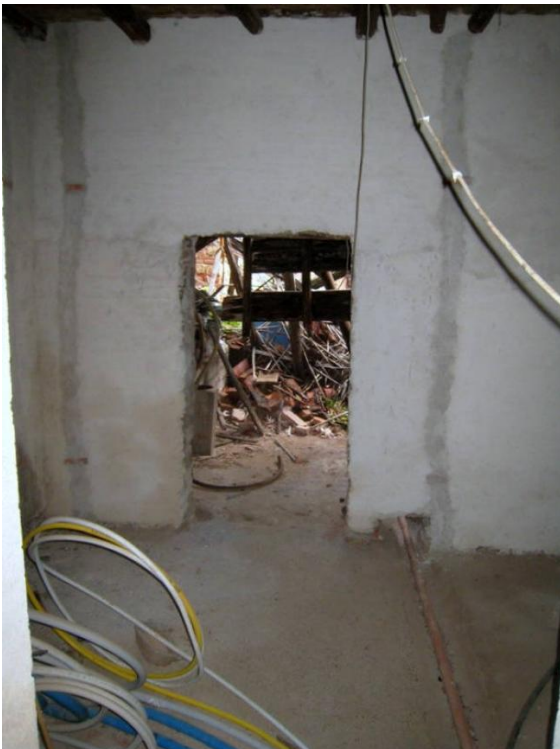
Foto n. 28. Una delle due stanze del sub 4 (unità collabente) in fase di restauro.
