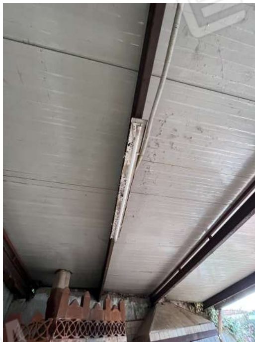
Foto 9 - Tettoia della cucina esterna
