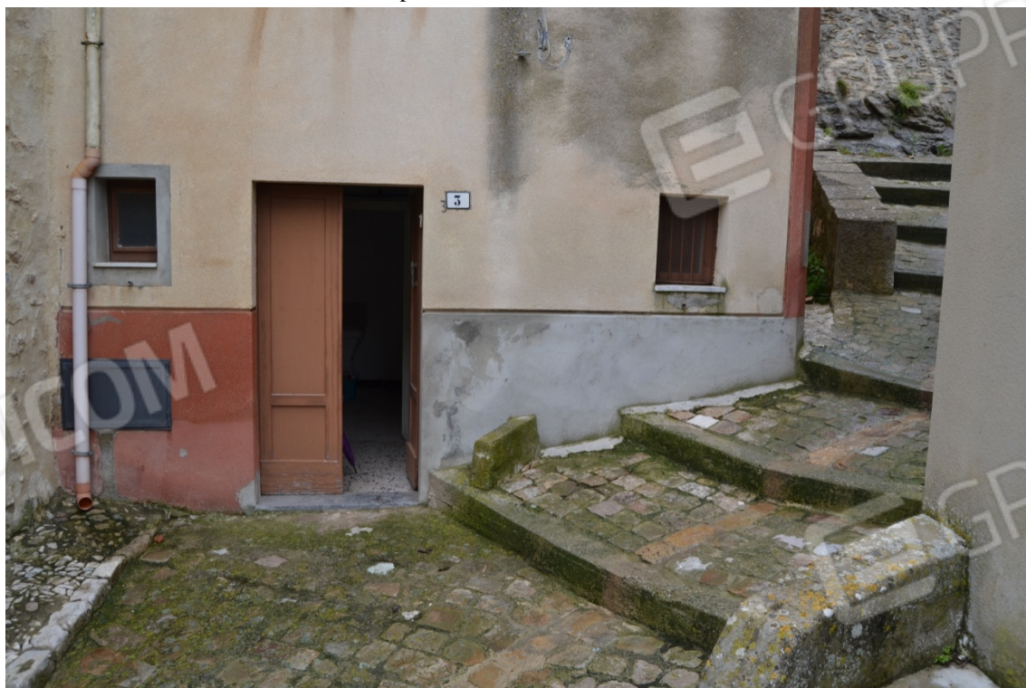
Fotografia 6 – Ingresso via Della Croce n. 3
