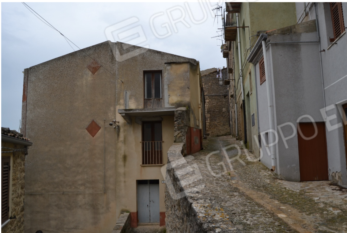
Fotografia 5 – Prospetto via Della Croce n. 5
