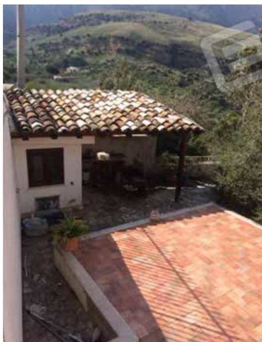
Foto 10. Casotto attrezzi adibito a servizio igienico.
