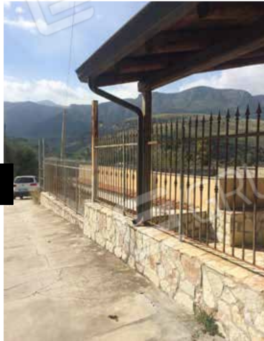
Foto 3. Accesso all'immobile da contrada Danigarci snc.
