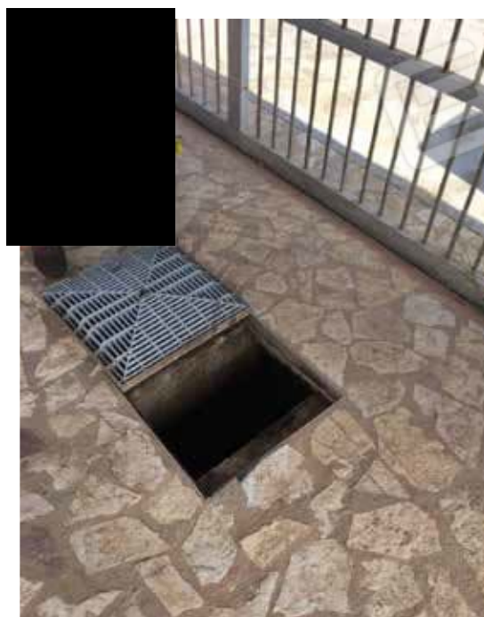
Foto 6. Cisterna ispezionabile dallo spazio adibito a parcheggio.
