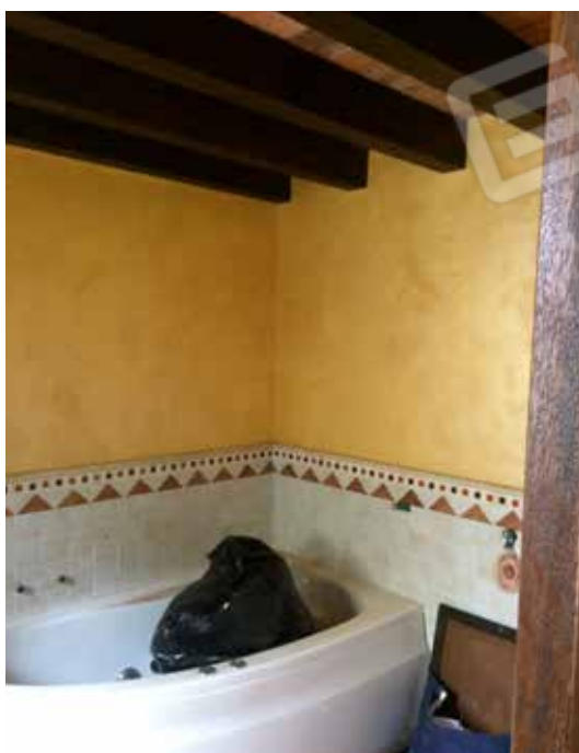
Foto 24. Servizio igienico a servizio della camera da letto.
