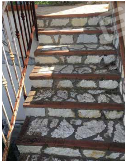
Foto 8. Scala esterna di collegamento tra il piano stradale ed il piano di accesso all'immobile.
