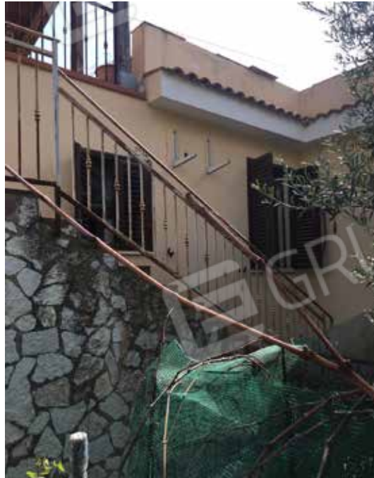
Foto 7. Scala esterna di collegamento tra il piano stradale ed il piano di accesso all'immobile.
