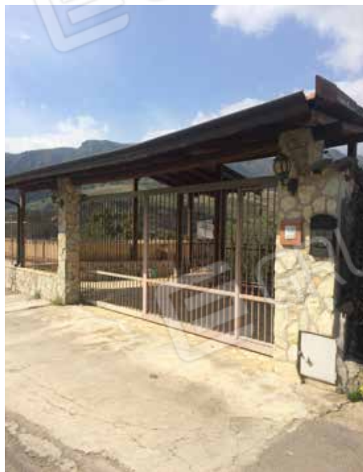
Foto 1. Accesso all'immobile da contrada Danigarci snc.
