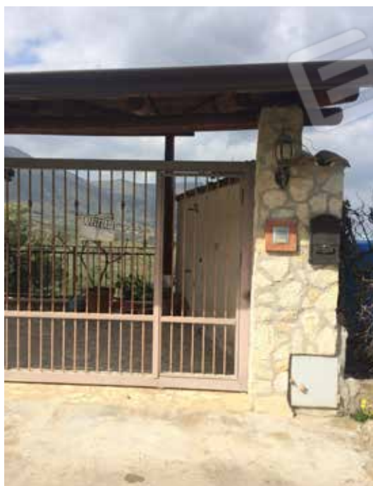
Foto 2. Accesso all'immobile da contrada Danigarci snc.
