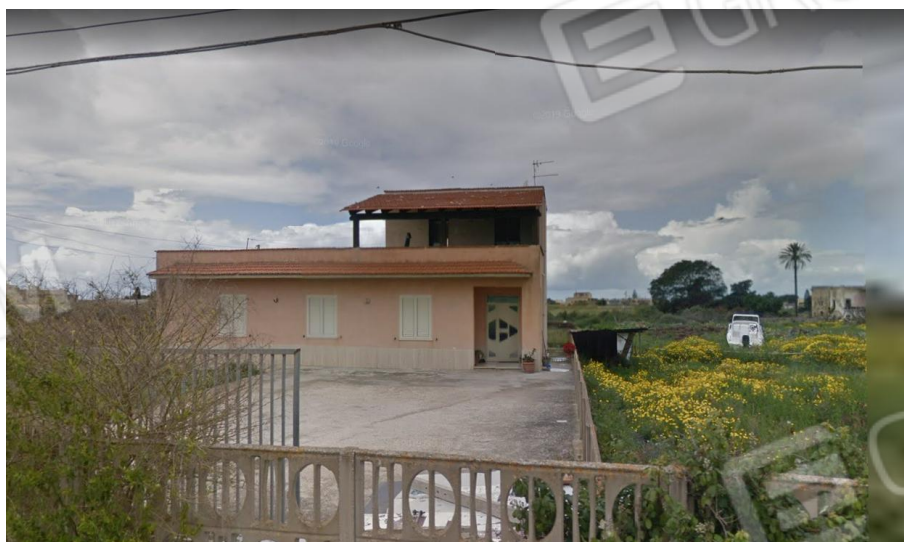
Foto n. 2 Vista immobile da strada Ballottella
