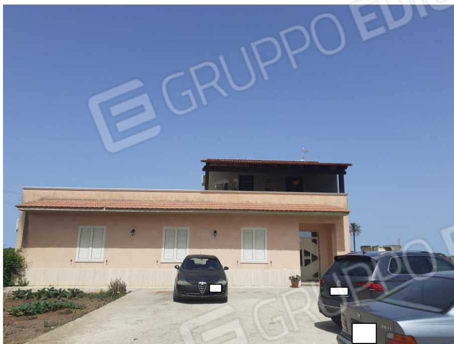
Foto n. 23 vista prospetto principale- veranda- area di pertinenza - area vincolata a parcheggio
