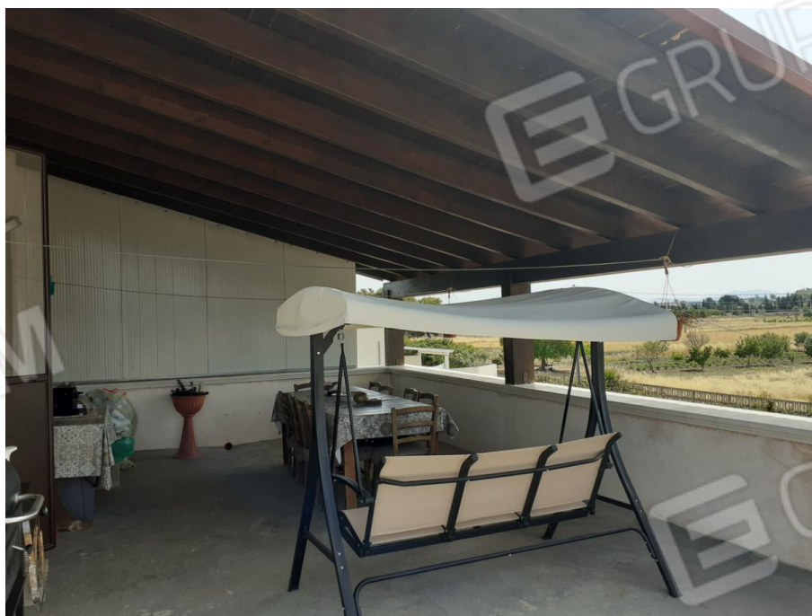
Foto n. 20 Vista della tettoia
