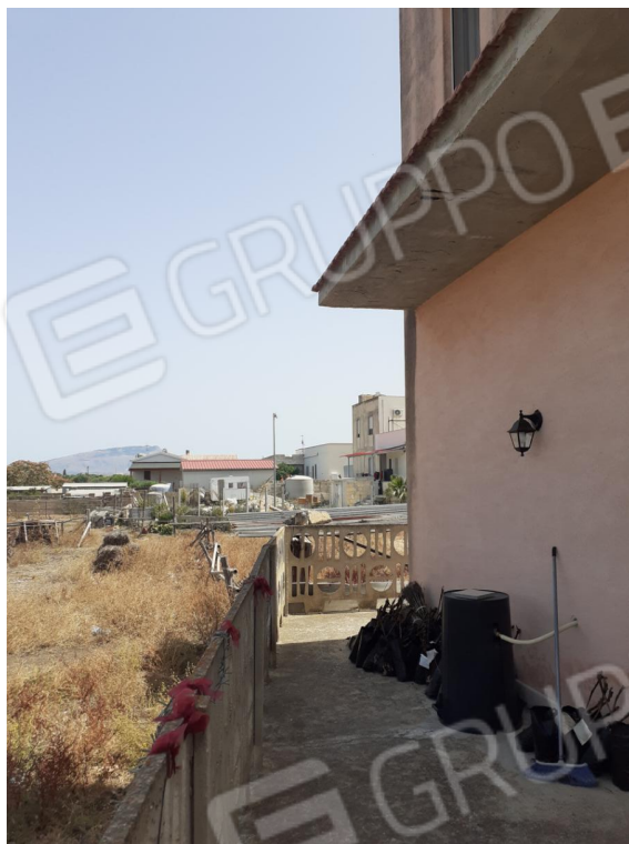
Foto n. 15 Vista aree di pertinenza p. t.
