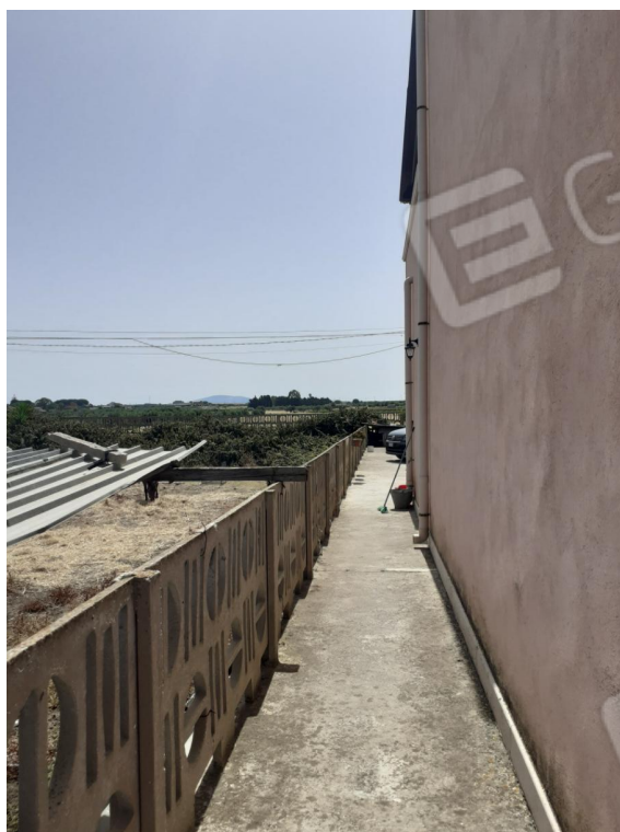
Foto n. 16 Vista aree di pertinenza p. t.
