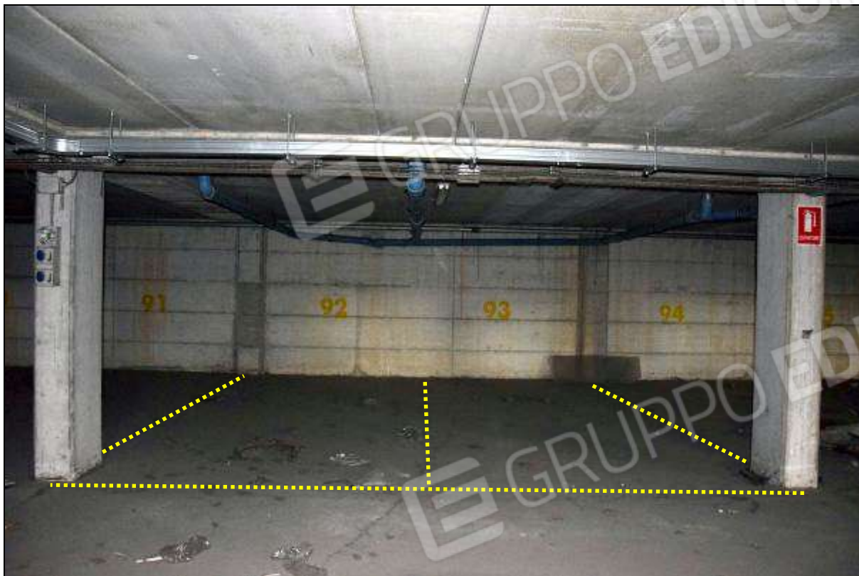
FOTO 7 – SUB 79 (POSTO 92) / SUB 80 (POSTO 93)
