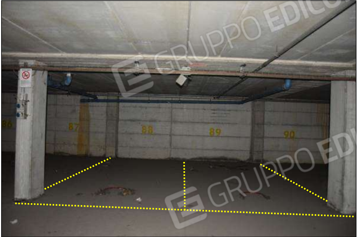
FOTO 5 – SUB 75 (POSTO 88) / SUB 76 (POSTO 89)
