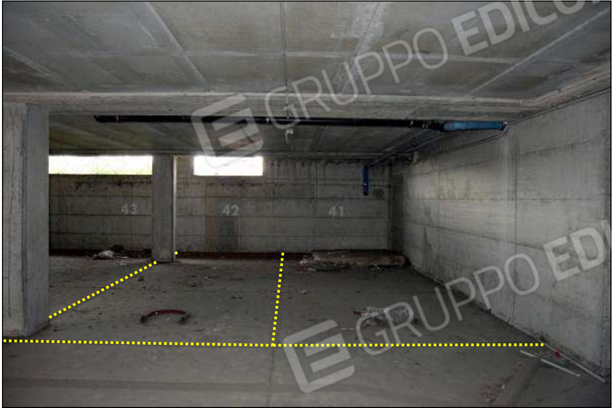
FOTO 1 – SUB 108 (POSTO 42) / SUB 109 (POSTO 41)
