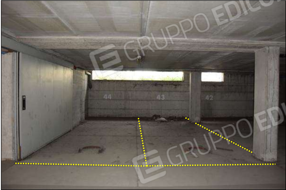
FOTO 1 – SUB 106 (POSTO 44) / SUB 107 (POSTO 43)
