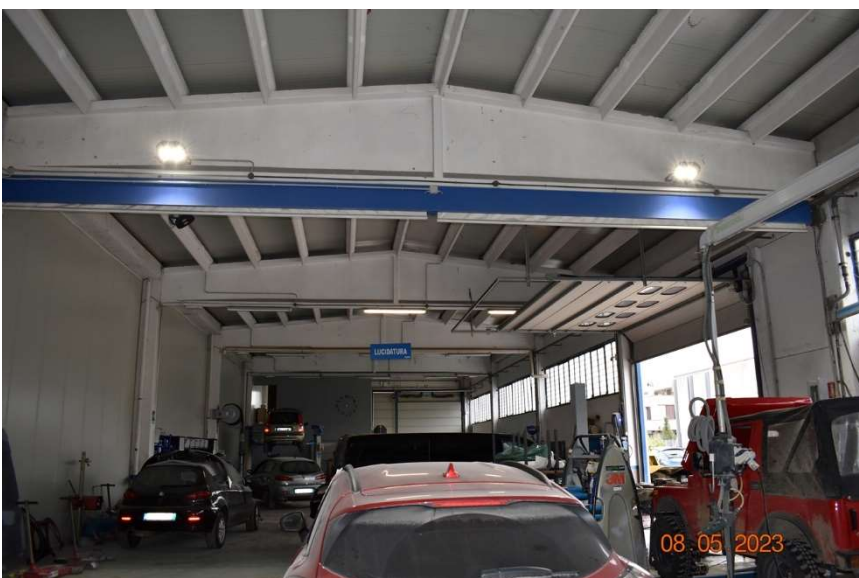
Foto 06 Vista interna del capannone
