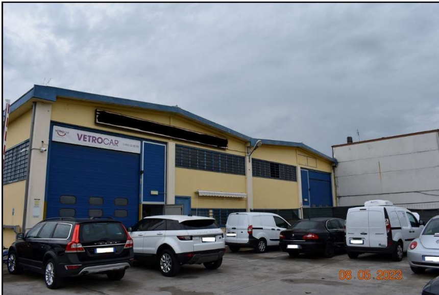
Foto 01 Facciata Nord-Ovest – su Via Maestri del Lavoro
