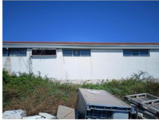
Conigliera in struttura metallica e tamponamento in laterizio e copertura in pannello coibentato
