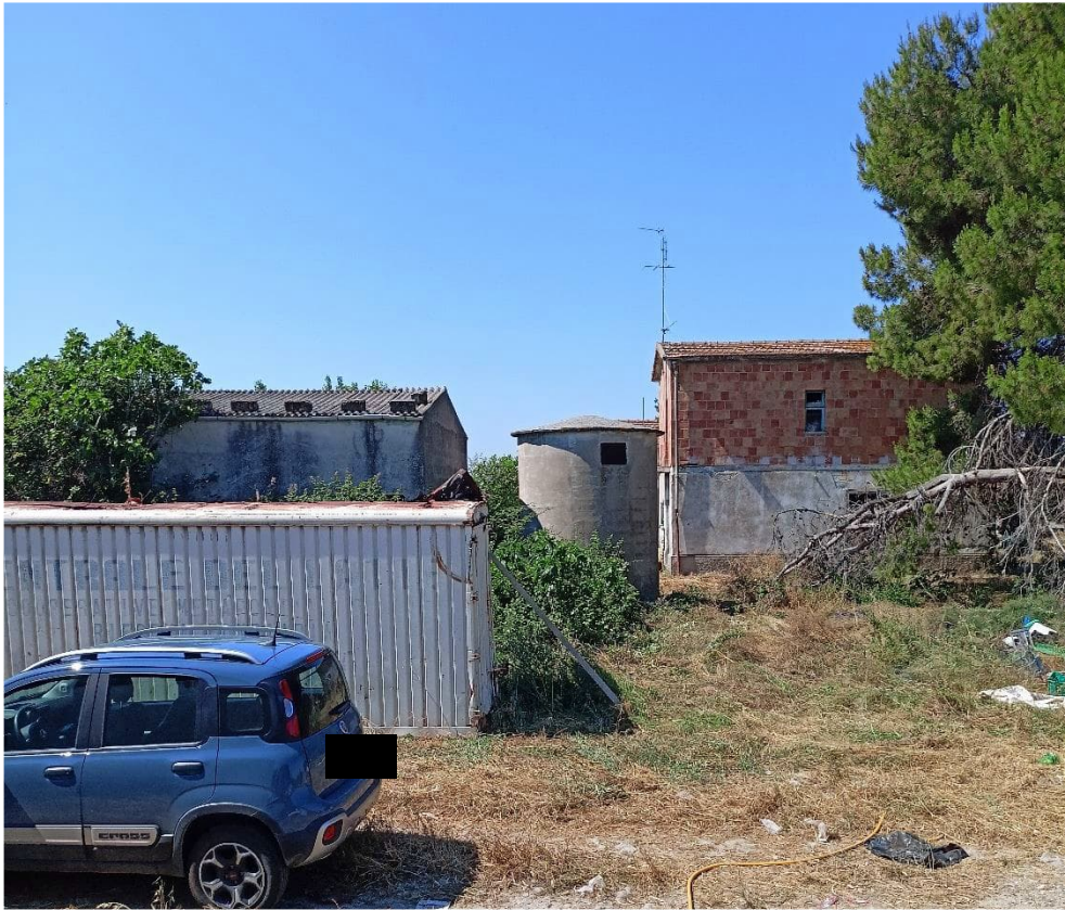
Deposito in muratura di tufo
