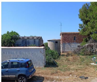
Deposito in muratura di tufo
