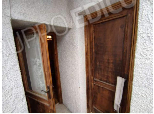
foto 25 – vista dal terrazzino verso il soggiorno
