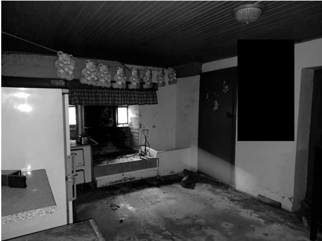
Foto n. 5 : C.F. Fg. 29 mapp. 33 - Piano terra, cucina
