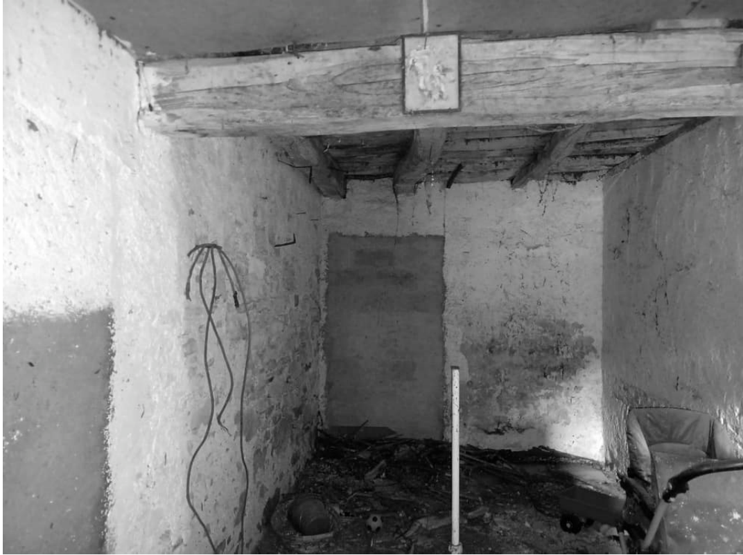
Foto n. 7 : C.F. Fg. 29 mapp. 33 - Piano terra, cantina
