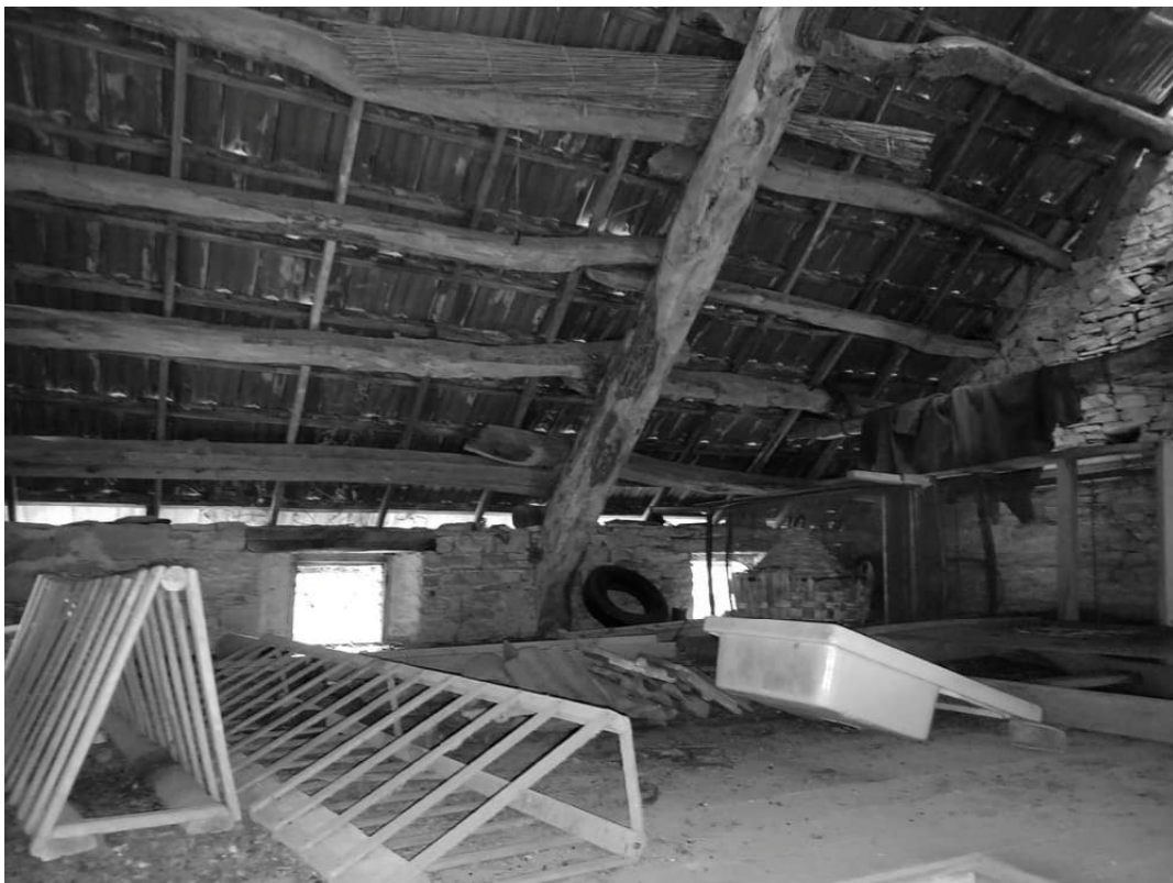
Foto n. 10 : C.F. Fg. 29 mapp. 33 - Piano secondo sottotetto, soffitta
