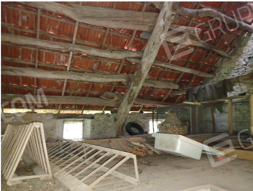
Foto n. 10 : C.F. Fg. 29 mapp. 33 - Piano secondo sottotetto, soffitta
