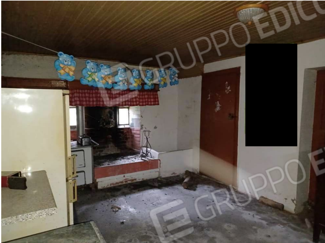
Foto n. 5 : C.F. Fg. 29 mapp. 33 - Piano terra, cucina
