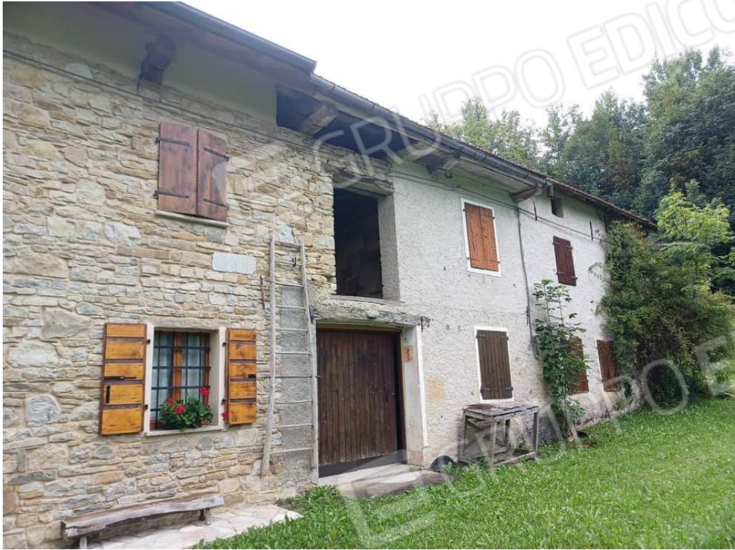
Foto n. 1 : C.F. Fg. 29 mapp. 33 - Porzione di fabbricato residenziale, vista da nord
