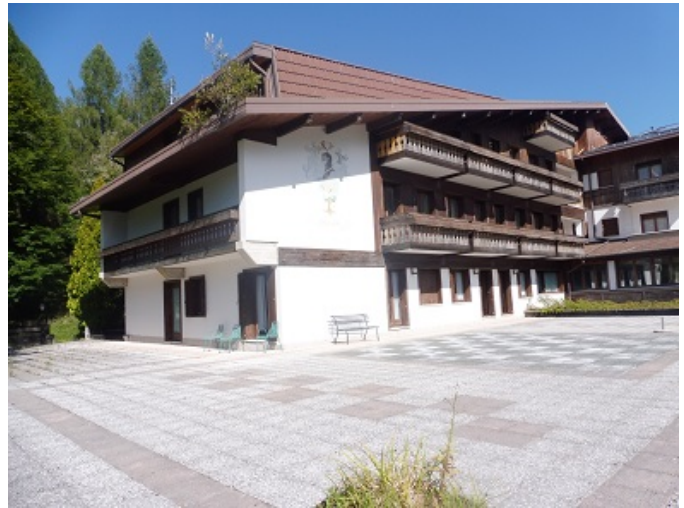
La facciata laterale rivolta a sud-ovest, vista dalla terrazza del primo piano
