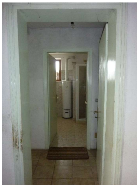
Vista interna dei locali da sanare al piano terra sub. 3
