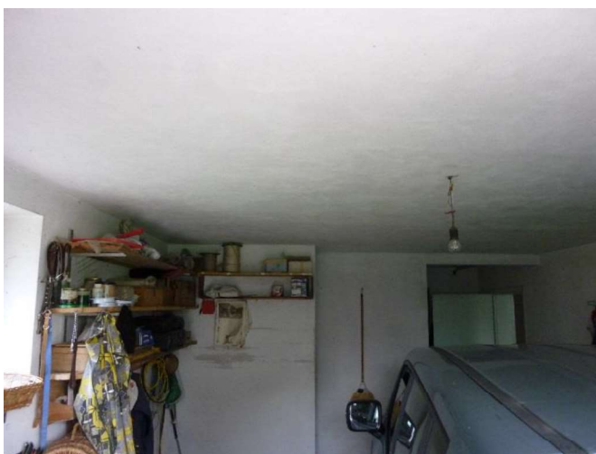
Vista interna zona nord dell'autorimessa al sub. 3
