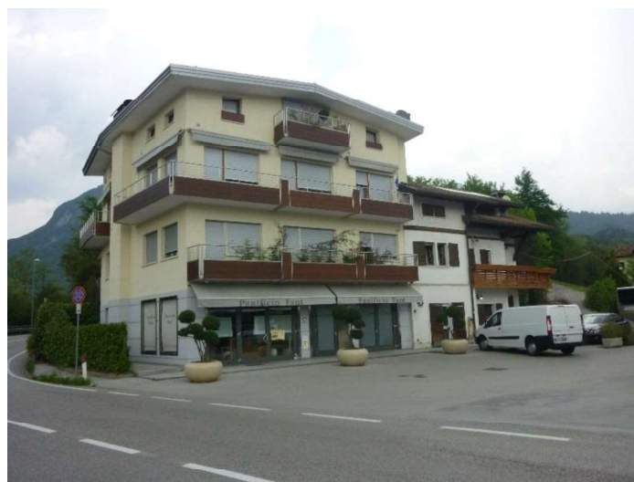
Vista dei prospetti ovest e sud (angolo fra la via Dolomiti e la Piazza I° Maggio) Del fabbricato principale
