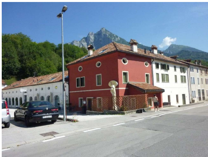
Prospetti est e sud (del condominio “Bacologico n. 1”, distinto con tonalità rossa) in cui si pongono i beni dei lotti n. 1 e n. 2 che si collocano nella zona mansardata
