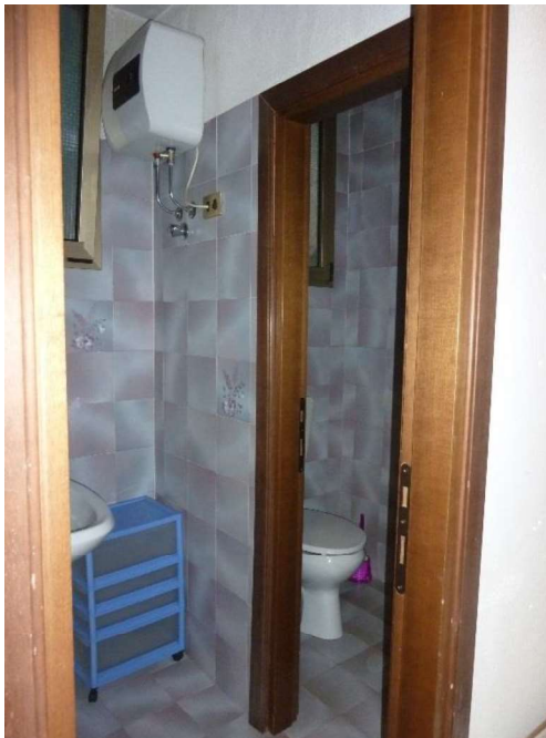
Particolare interno servizi posti nel sotto negozio
