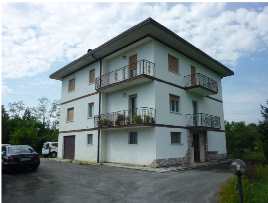
Vista dei lati nord e est del fabbricato al mapp. 252 comune di Sospirolo
