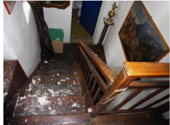
49 Vista del servizio igienico dalla scala
