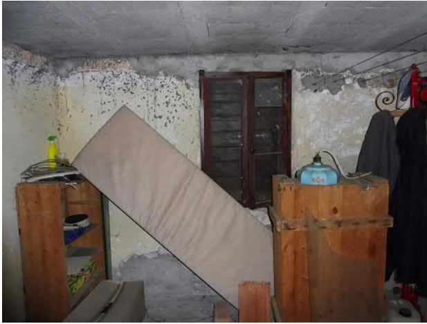
58 Il locale deposito al 1° piano
