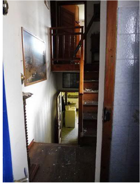
47 Vista dal servizio igienico verso la scala
