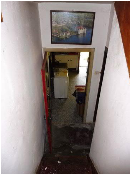
60 Rampa della scala: vista verso la Cucina al piano terra
