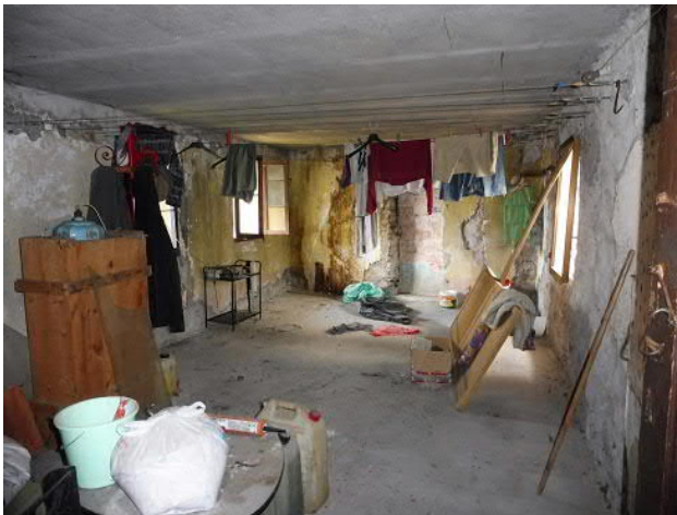
54 - 55 Il locale deposito al 1° piano
