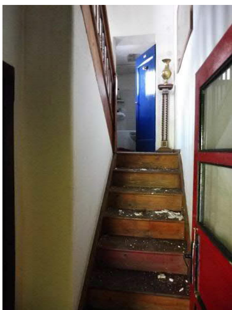
33 La scala; sul pianerottolo intermedio si vede la porta d'ingresso al servizio igienico
