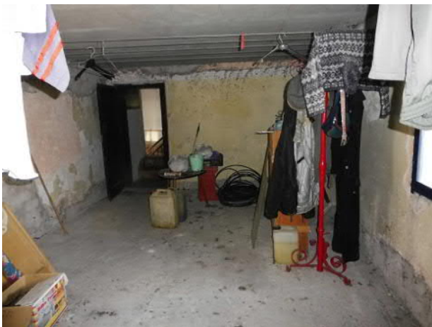
56 - 57 Il locale deposito al 1° piano
