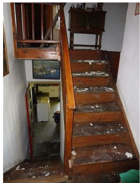
51 Il vano scala
