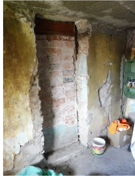
59 Il locale deposito al 1° piano: la parete di fondo con la porta tamponata
