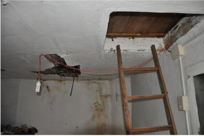
Foto 19 Disimpegno: la botola sul soffitto per l'accesso alla soffitta
