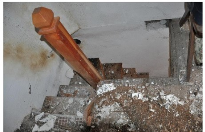
Foto 18 Disimpegno: la scala
