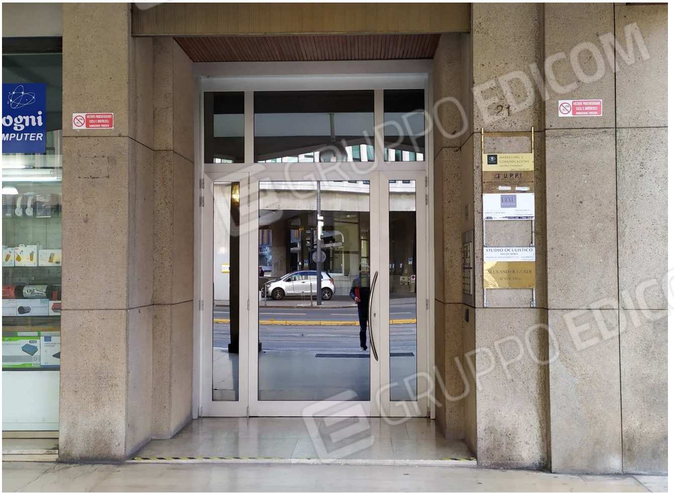
Veduta esterna dell'ingresso condominiale
