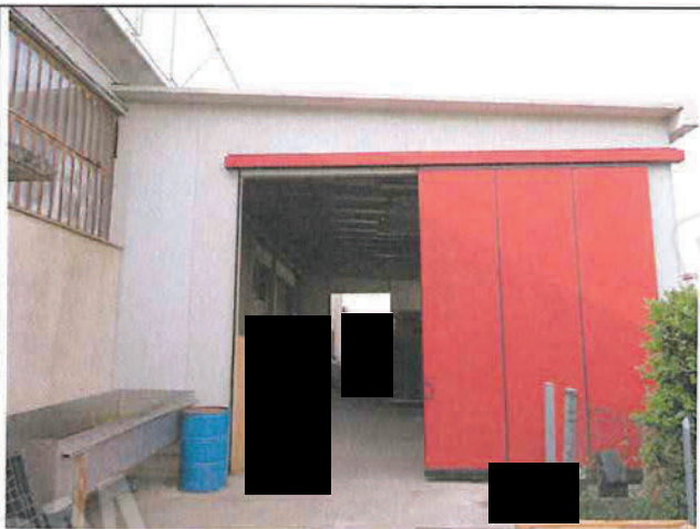
Foto n°189: Capannone piccolo abusivo ad est
