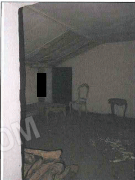
Foto n°245: Interni del sub 2 al P.1° fronte strada.
