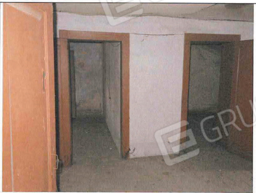
Foto n°242: Interni del sub 2 al P.1° fronte strada.
