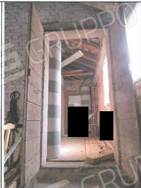
Foto n°234: Interni del sub 2 al P.1°
