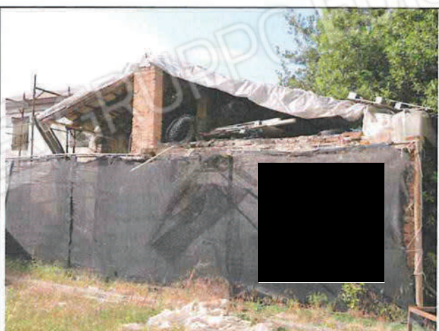
Foto n°216: Fronte sud parzialmente demolito
