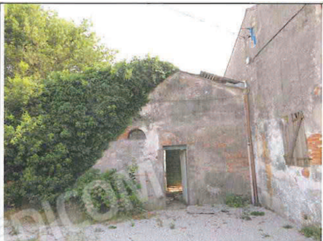
Foto n°217: Fronte nord est
