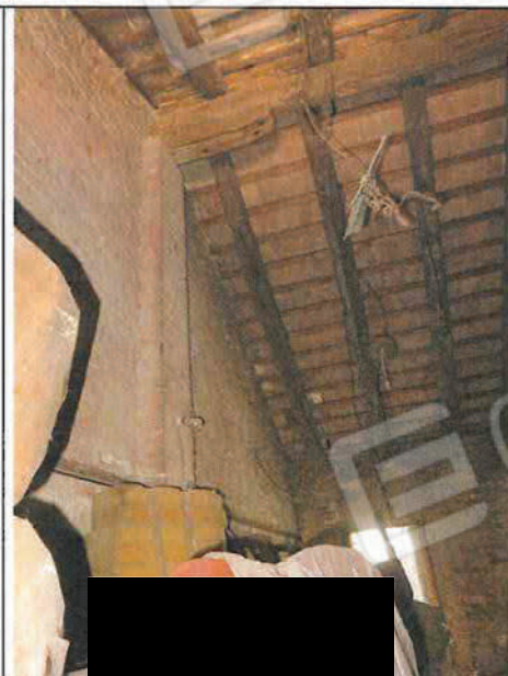
Foto n°236: Interni del sub 2 al P.1°
