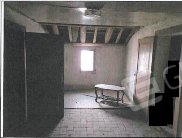
Foto n°243: Interni del sub 2 al P.1° fronte strada.
