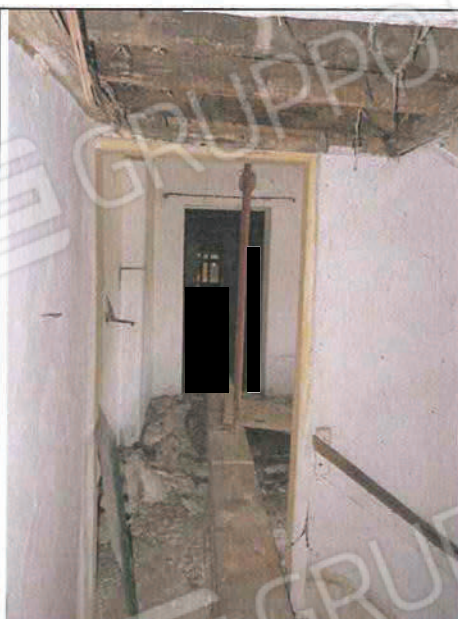
Foto n°246: Interni del sub 2 al P.1° fronte strada.
