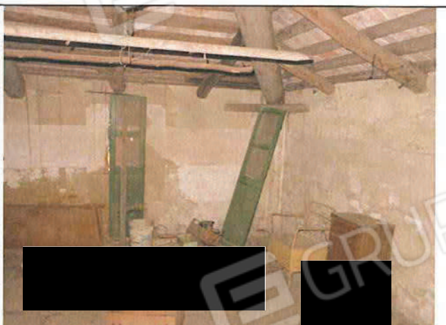
Foto n°248: Interni del sub 2 al P.1° fronte strada.
