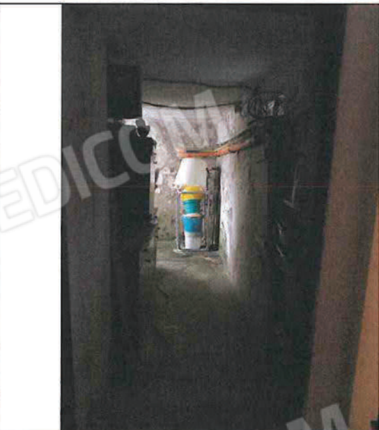
Foto n°33: Cavedio a sud-ovest
