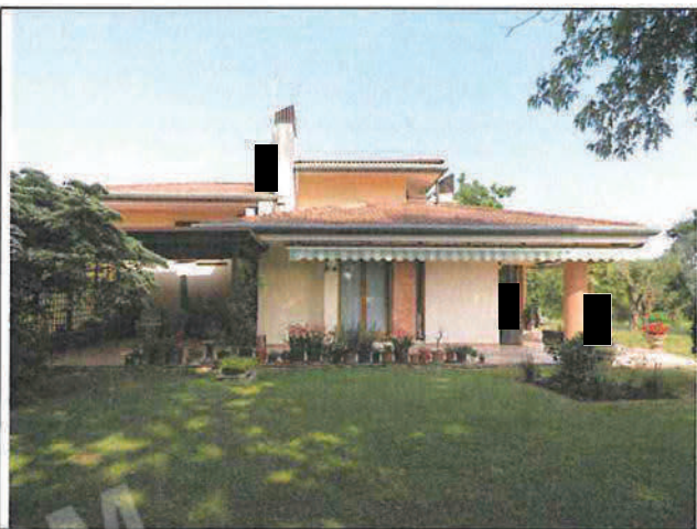
Foto n°13: Facciata ovest con gazebo
