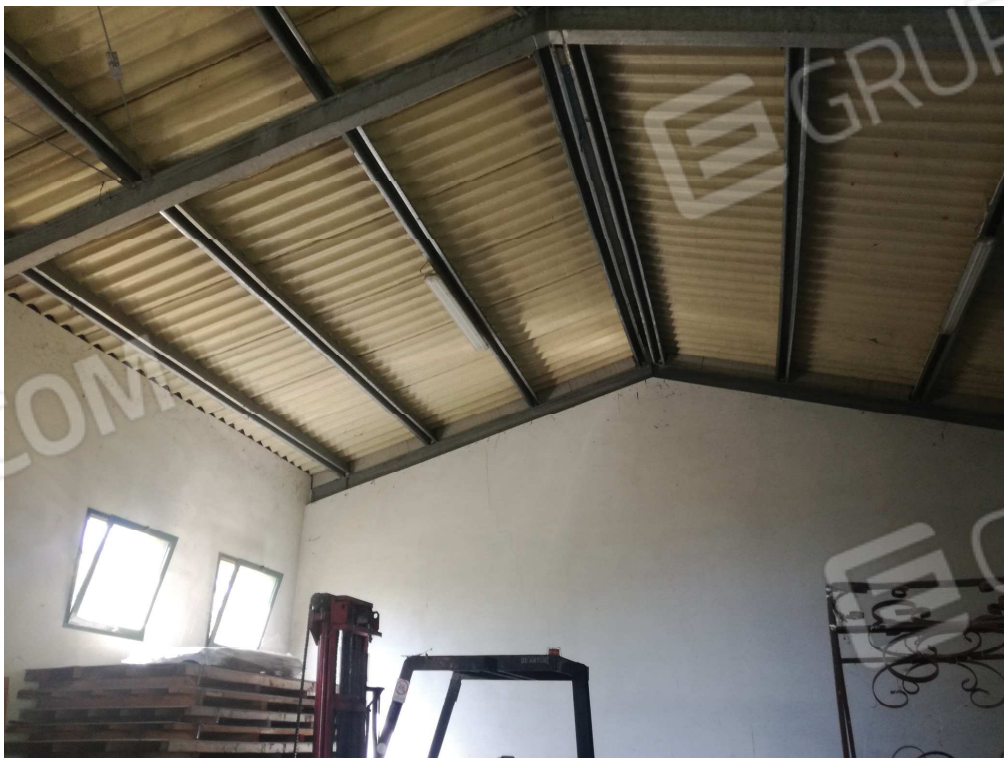
Particolare del Tetto
