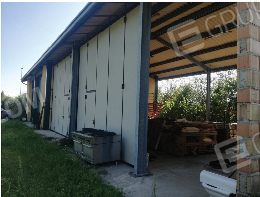
Capannone - particolare della porzione aperta - foto 2
