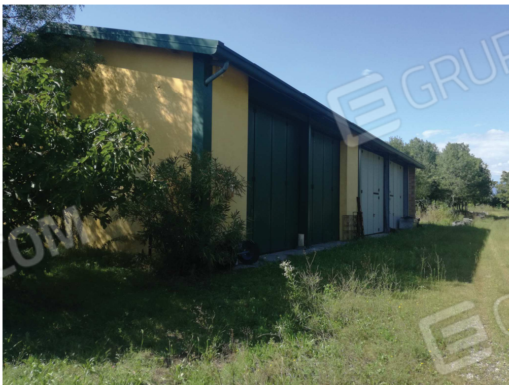
Capannone per ricovero attrezzatura - foto 1
