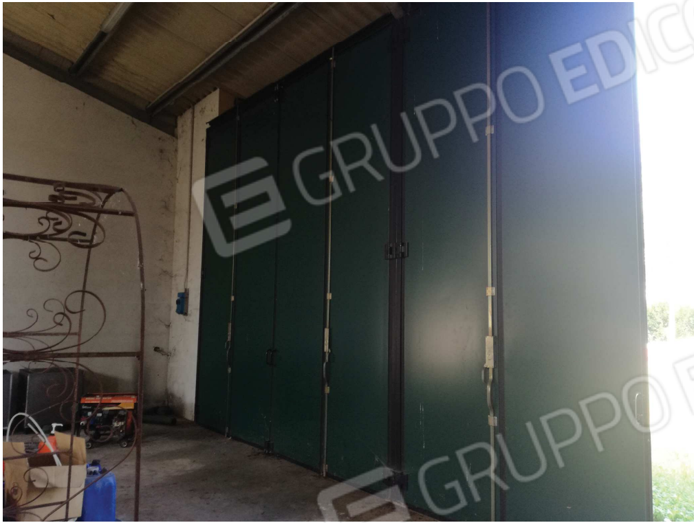
Particolare dei serramenti
