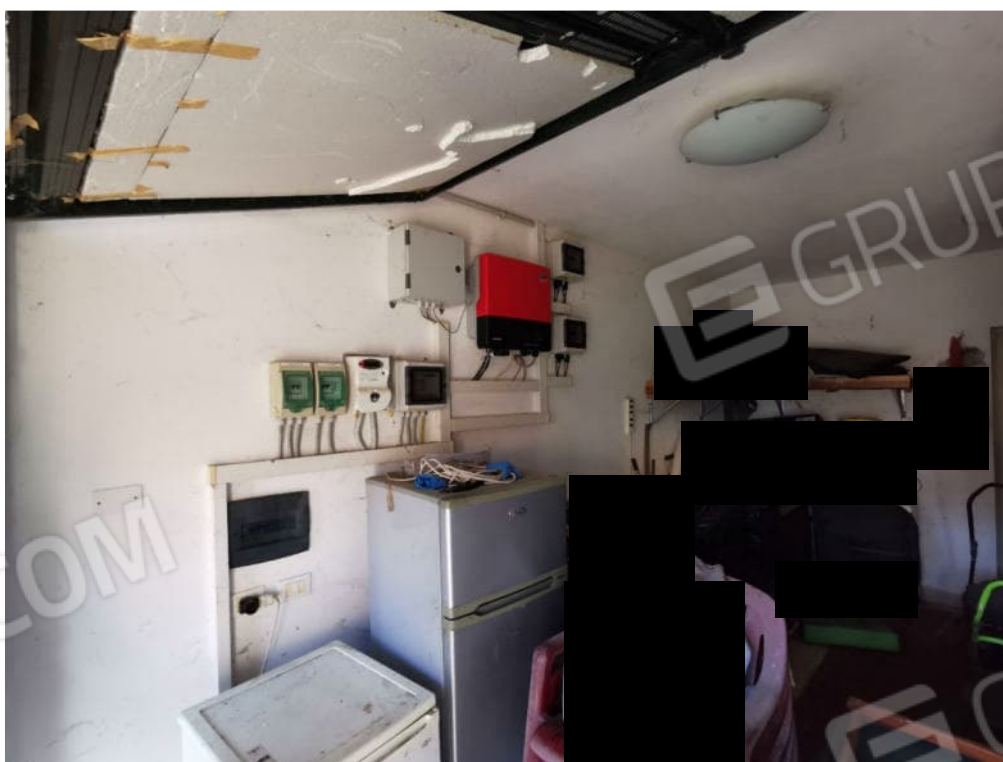
FOTOGRAFIA N.6 – particolare interno piano terra (garage)
