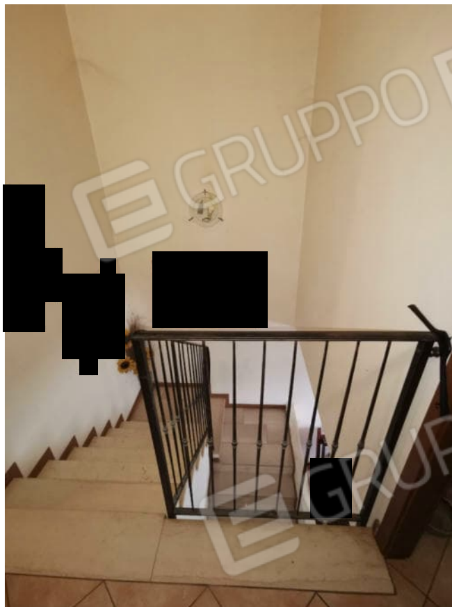
FOTOGRAFIA N.7 – particolare interno – vano scala
