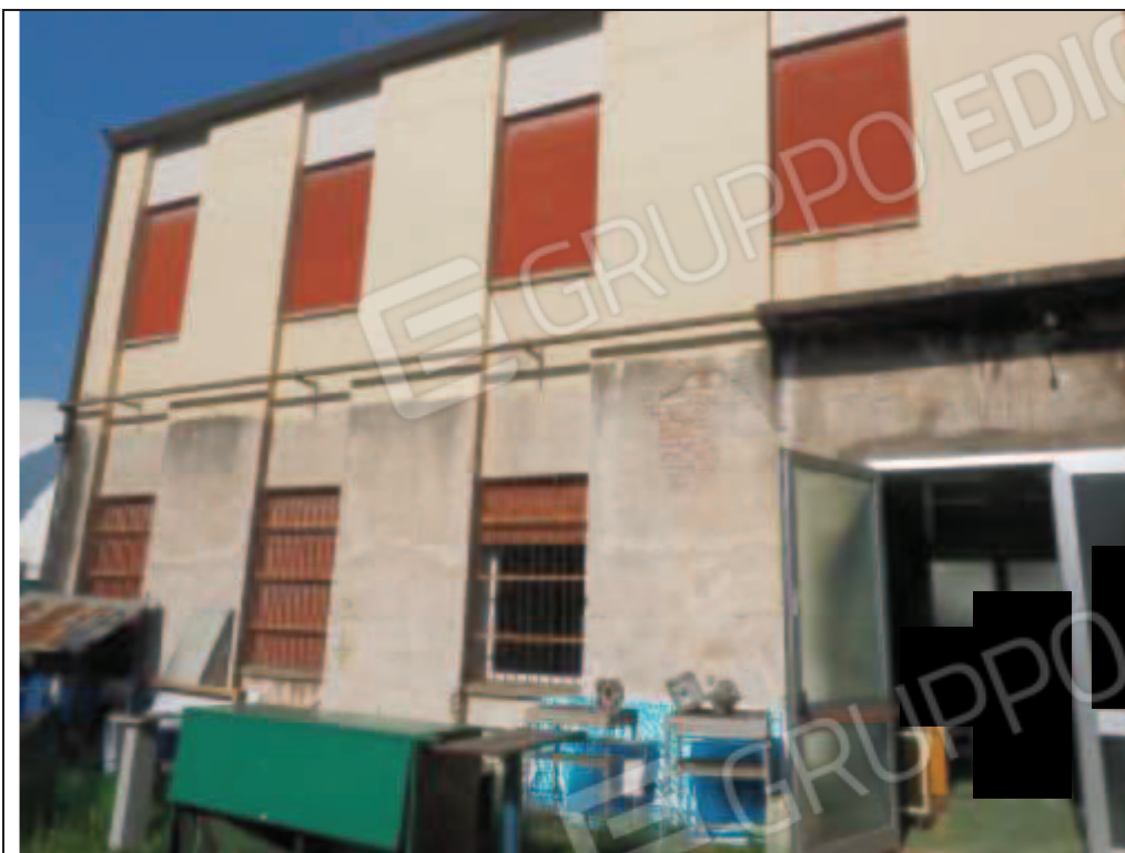
Figura 28 esterno blocco D
