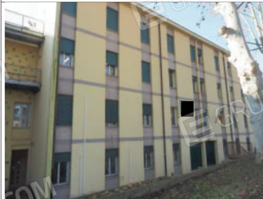
Figura 7 Blocco A veduta da Via Marconi (Nord)
