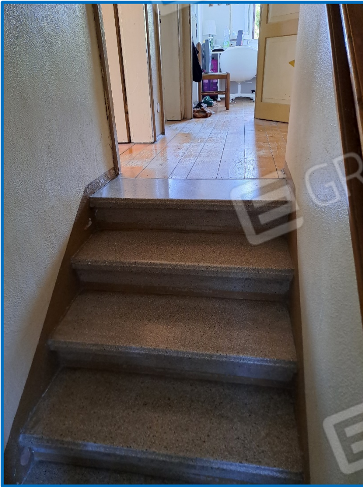
n° 11 – Interni piano ammezzato
