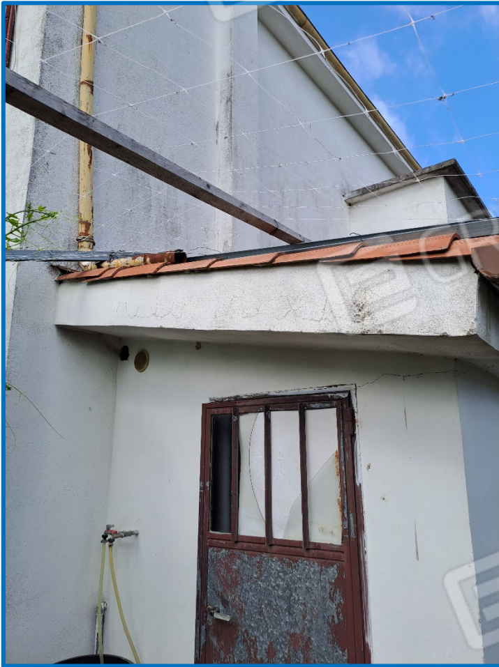
n° 9 – Esterno centrale termica
