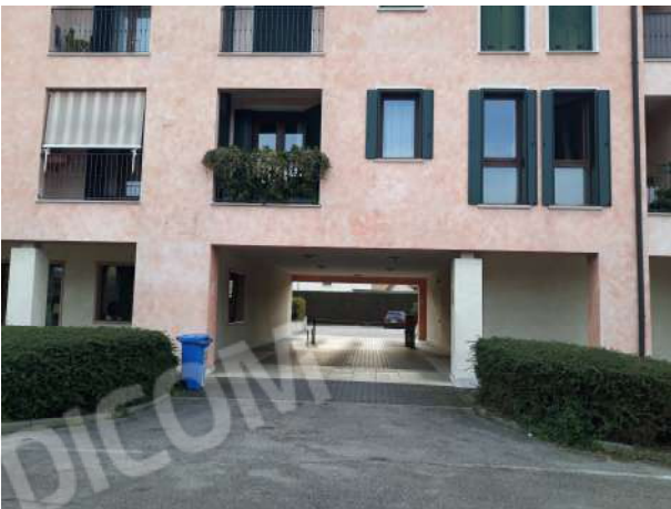
Foto 5 – portale accesso carrabile ad area interna
