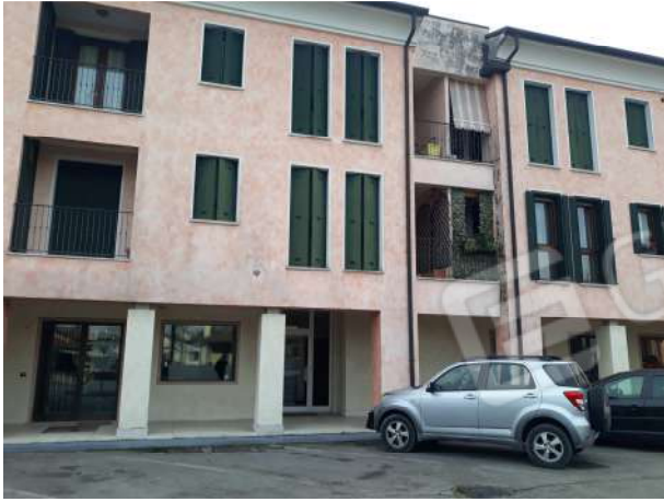
Foto 13 – ingresso vano scale
