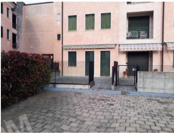
Foto 9 – accesso pedonale da area comune
