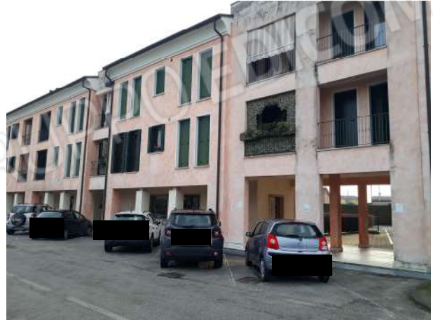
Foto 2 – prospetto ovest (ingresso)
