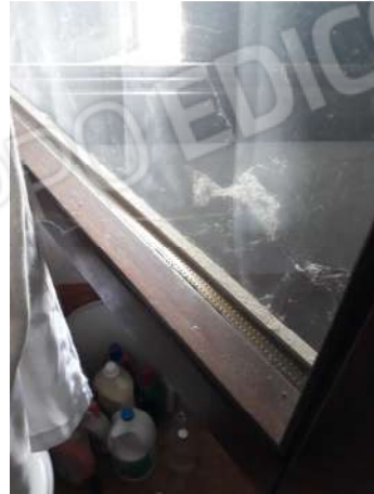
Foto 20 – particolare infissi esterni
