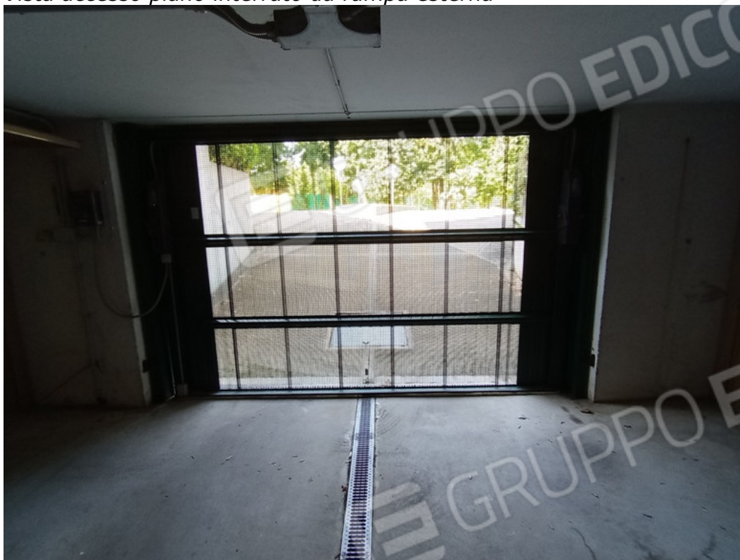
Vista accesso piano interrato da rampa esterna
