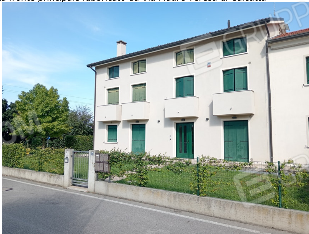
Vista fronte principale fabbricato da Via Madre Teresa di Calcutta
