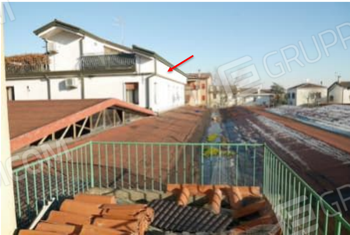
FOTO 18 - Corpo principale. Piano primo. Vista da una delle terrazze della copertura del corpo capannone e di una delle proprietà di terzi (con freccia rossa).
