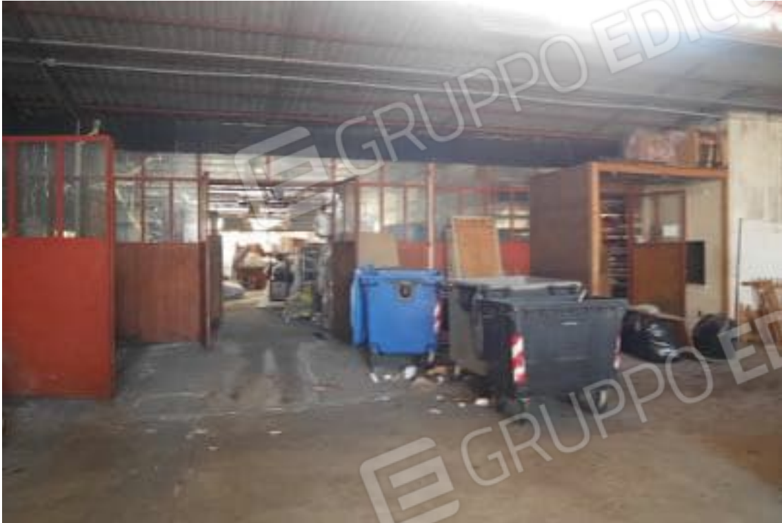
FOTO 11 - L'interno del corpo capannone formato da struttura e copertura in metallo.
