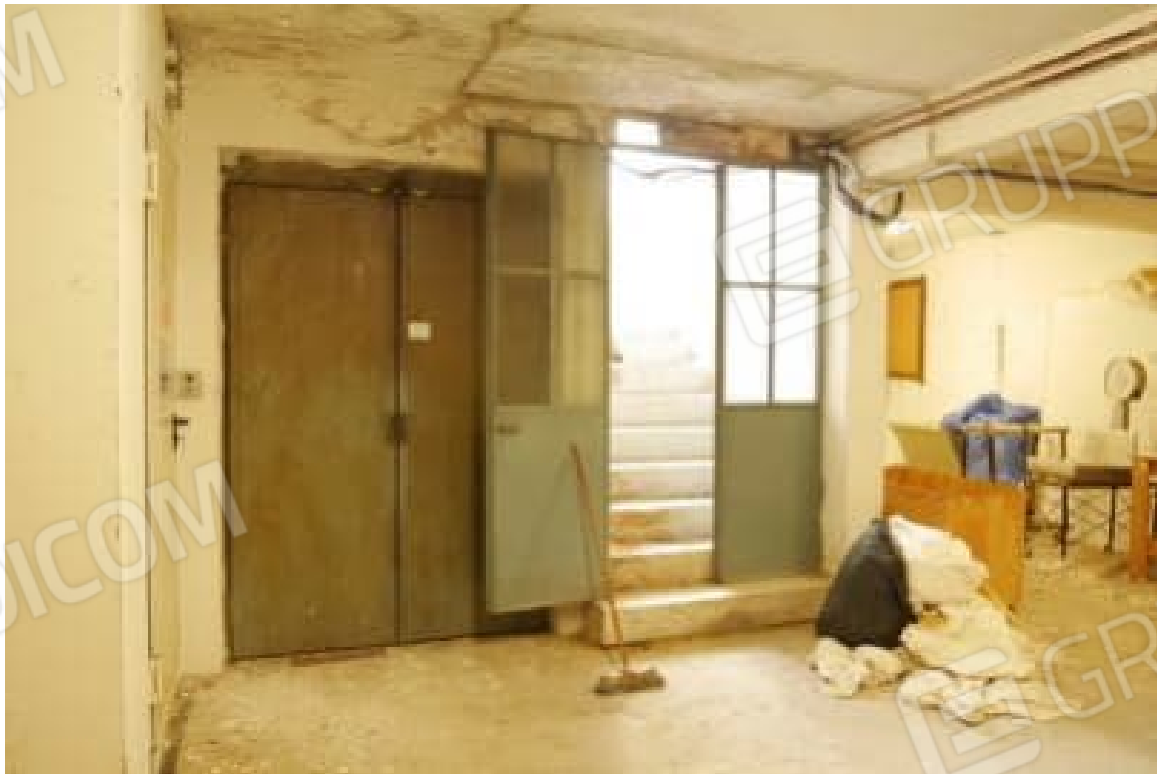
FOTO 26 - Corpo principale. Piano terzo. L'accesso alla terrazza ove sono allocate le antenne Ascom.
