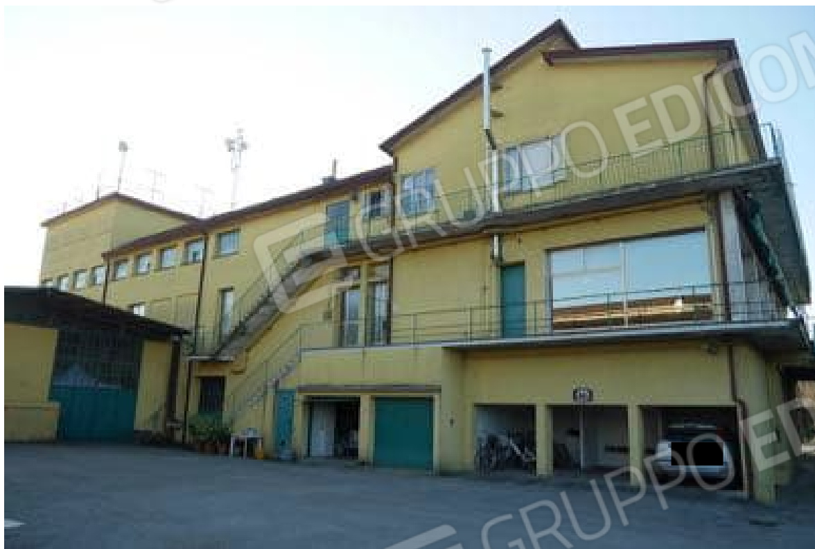
FOTO 5 - Il complesso dallo scoperto comune anche a terzi. In primo piano i cinque garage di proprietà di terzi.
