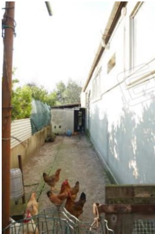
FOTO 14 – Lo scoperto a est del corpo capannone.
