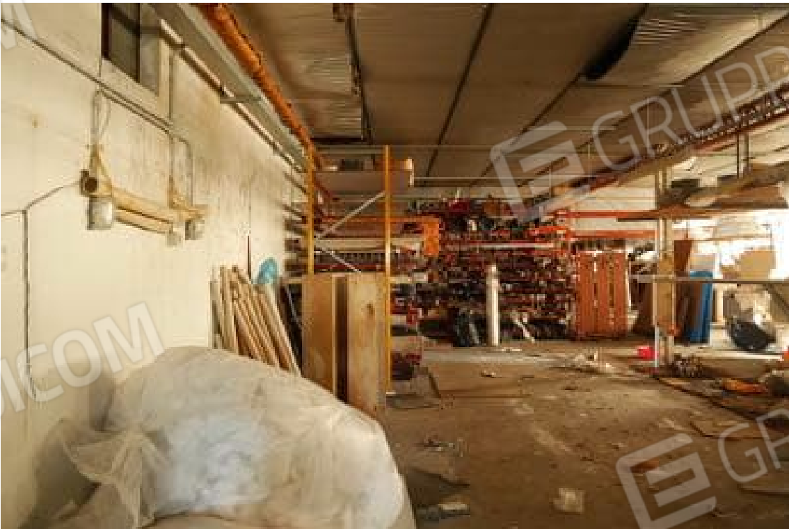
FOTO 12 - L'interno del corpo capannone formato da struttura e copertura in metallo.
