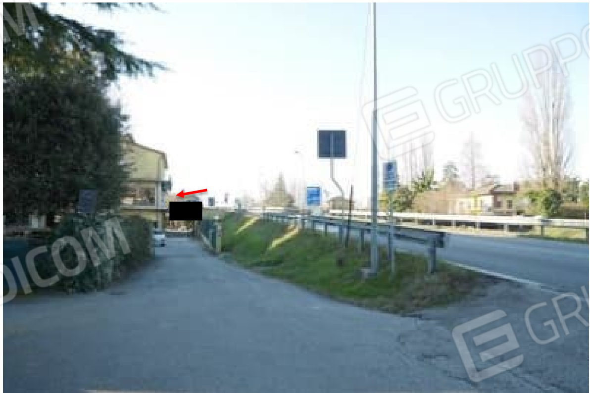
FOTO 4 - La strada di accesso al complesso. Con freccia rossa l'accesso al negozio esposizione di cui alla foto 2.
