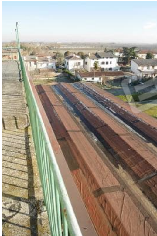
FOTO 10 - Vista della copertura del corpo capannone con manto in eternit rivestito da guaina impermeabile.
