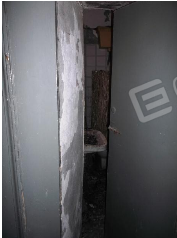
Uno dei due WC
