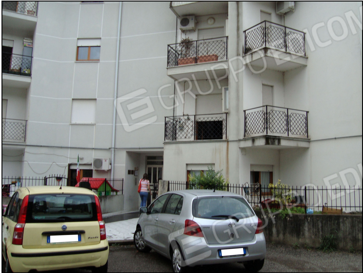
Foto 1 – Vista esterna del fabbricato sito in Montalto Uffugo (CS)
