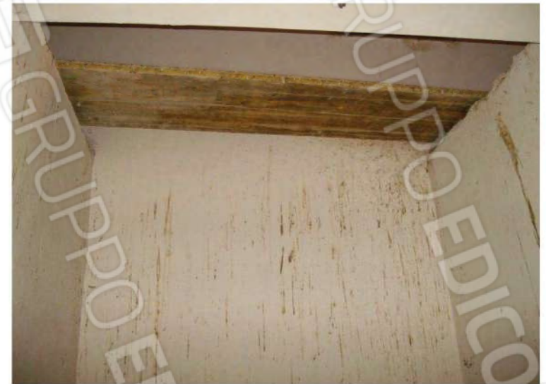
Foto n°41:– Sub n°4 , Piano Primo apertura solaio per accesso piano secondo sottotetto;
