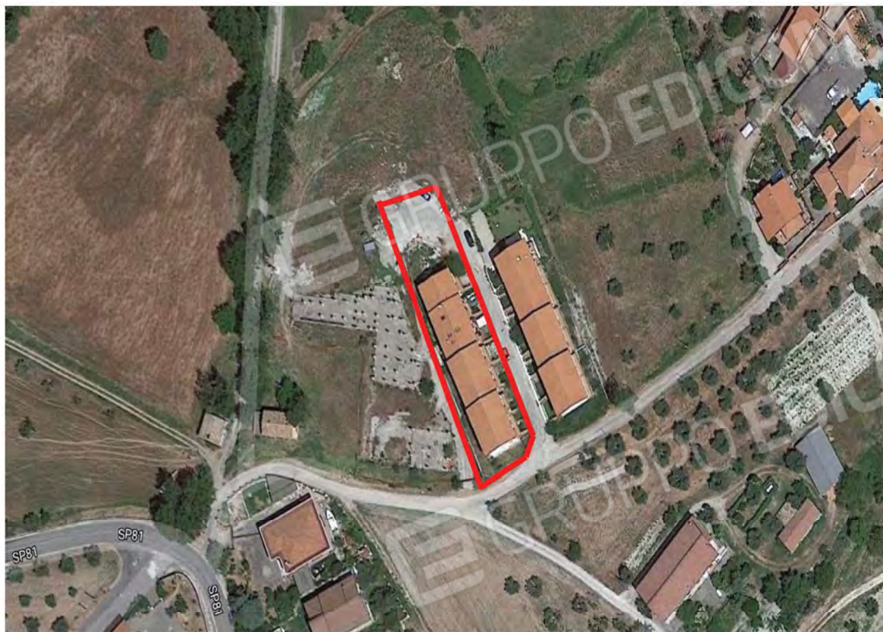
Foto n°1:– Vista dall’alto dei fabbricati facenti parte della massa fallimentare p.lla n°303;
