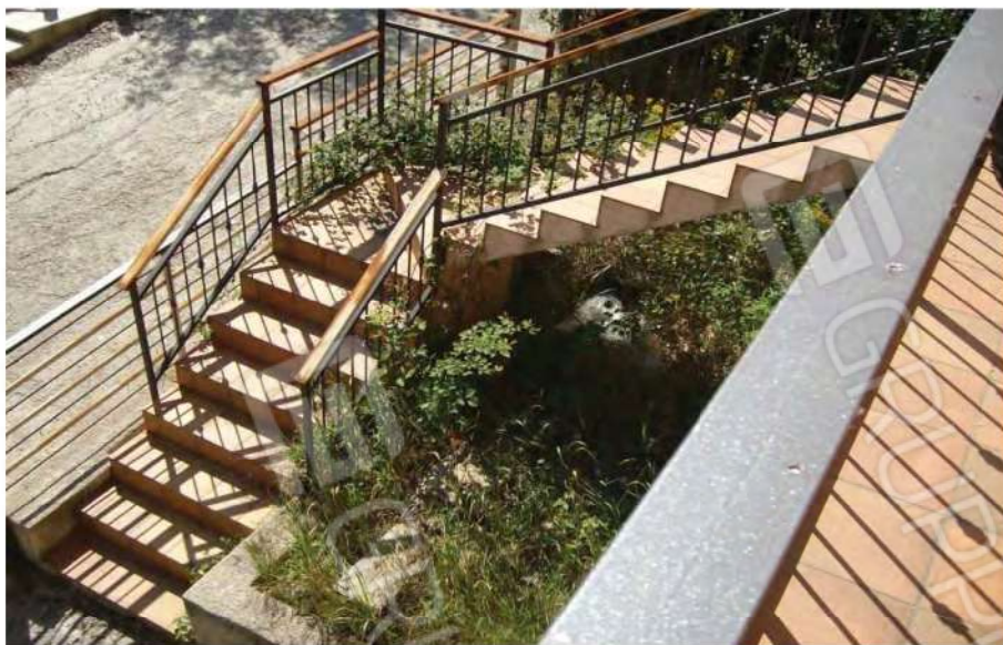
Foto n°37:– Sub n°4 , Scala Esterna;
