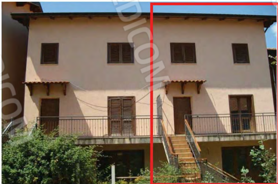
Foto n°36:– Sub n°4 , Vista Prospetto-Est;
