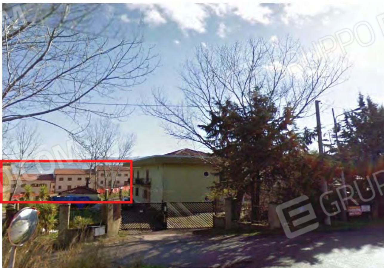
Foto n°2:– Vista dei fabbricati, p.lla 303, dalla Strada Provinciale “SP 81”;
