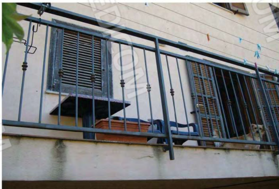
Foto n°50:– Sub n°6, Balcone piano terra sul prospetto Ovest;
