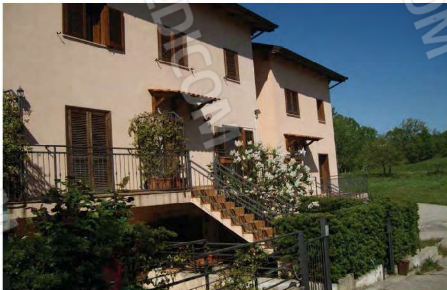
Foto n°46:– Sub n°6 , Prospetto Est;
