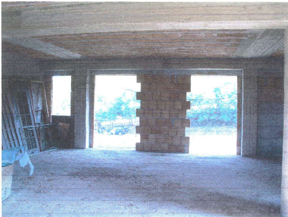
Figura 10 vista interna sub 11
