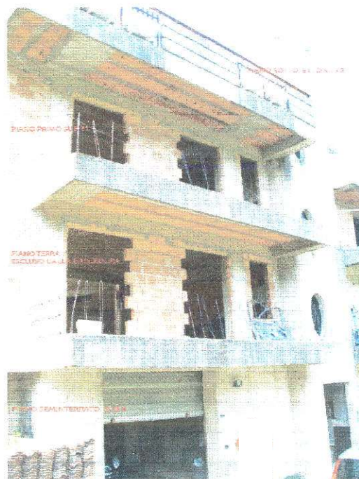
Figura 5 prospetto Sud: ingresso al magazzino
