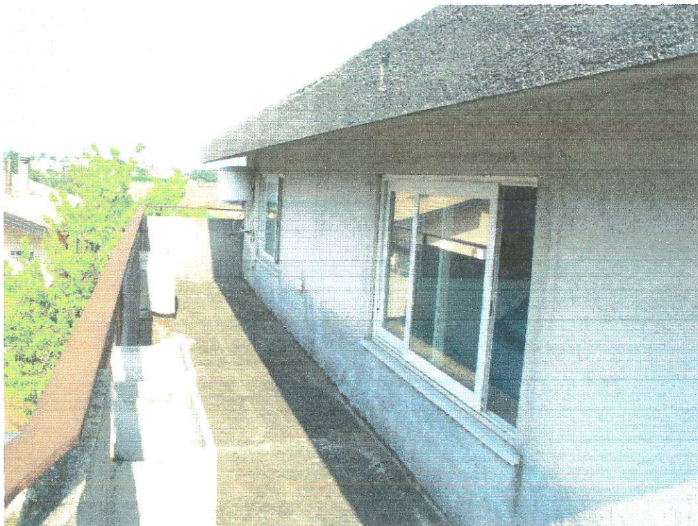
Figura 17 vista laterale locale sottotetto
