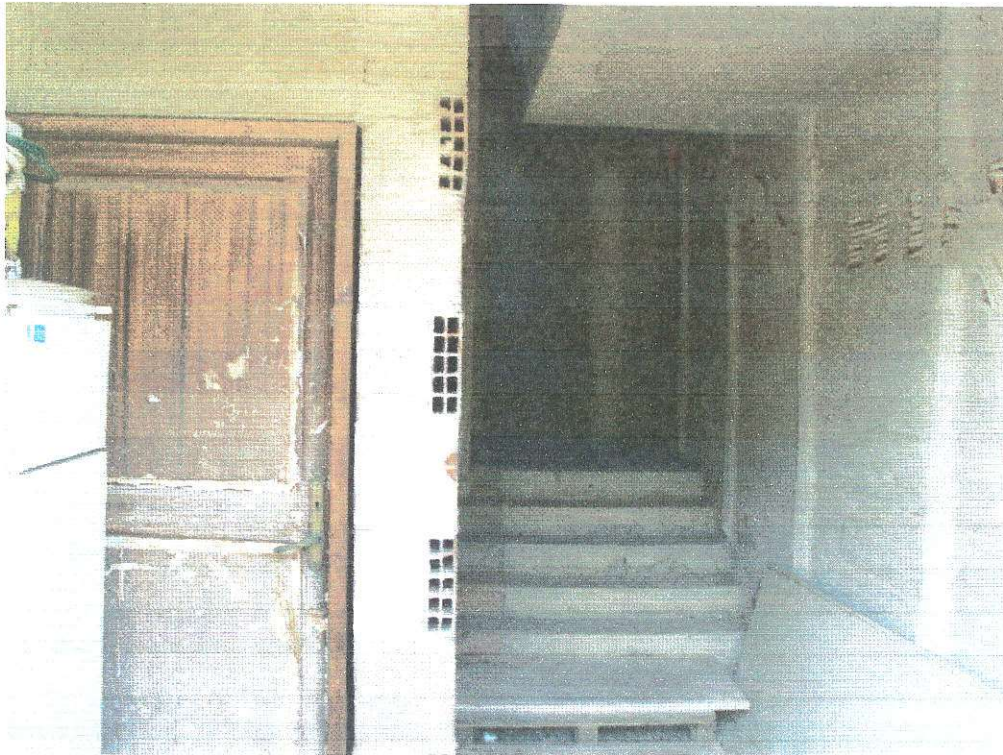
Figura 26 ingresso corpo scala
