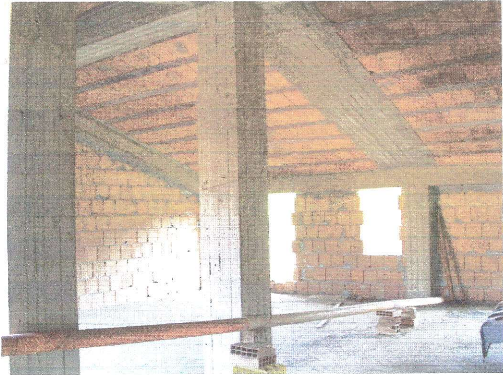
Figura 8 vista interna sub 12
