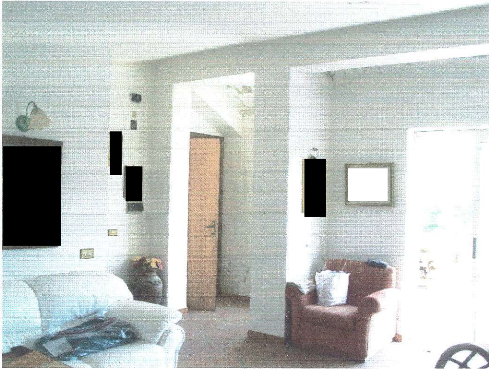
Figura 24 vista locale sottotetto
