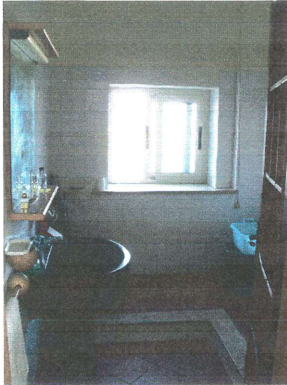
Figura 20 servizio igienico locale sottotetto
