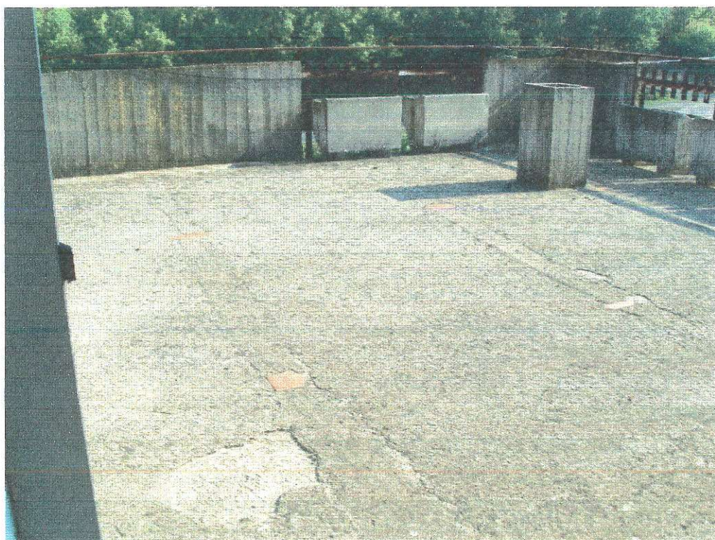
Figura 23 terrazzo adiacente locale sottotetto
