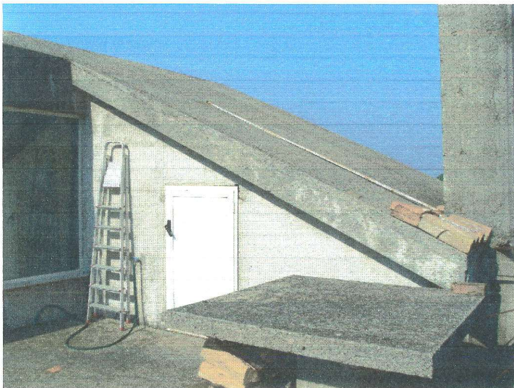
Figura 14 vista piano sottotetto: terrazzo e copertura corpo scale
