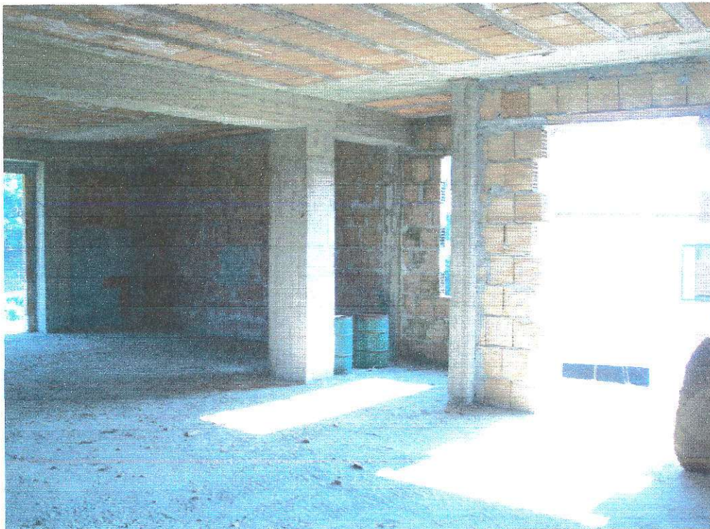
Figura 9 vista interna sub 11
