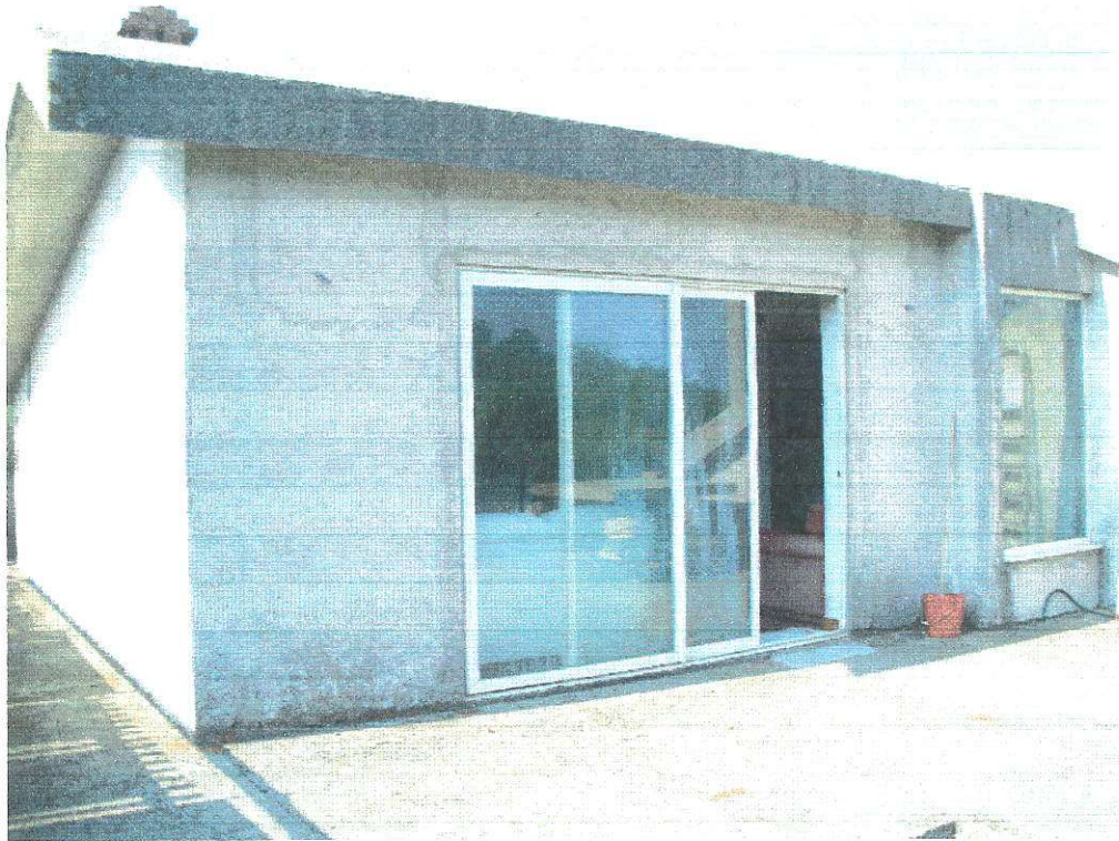
Figura 16 vista locale al sottotetto adibito ad abitazione
