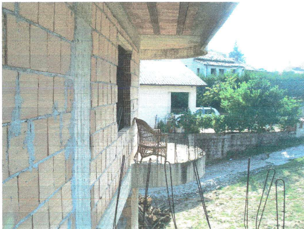
Figura 11 vista esterna sub 11
