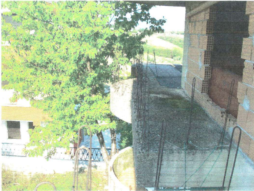
Figura 12 vista esterna sub 12
