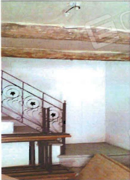
foto n°11_Particolari interno stanza n°1_PT
