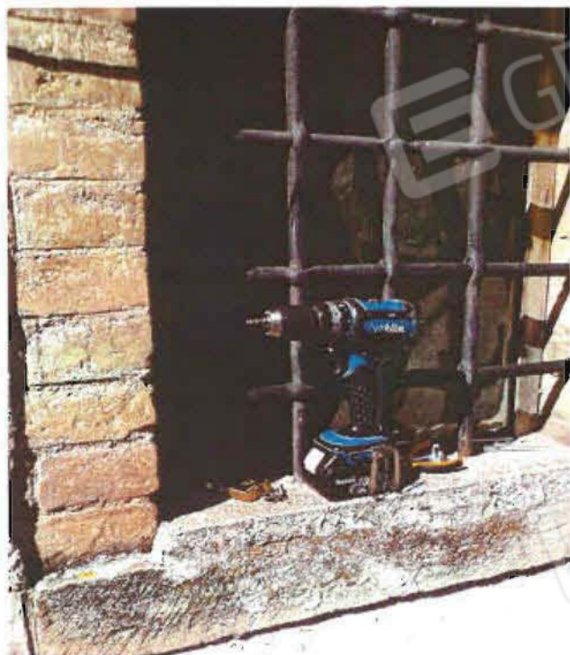
foto n°39 _Particolare chiusura portoncino ingresso
