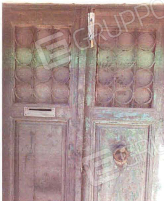
foto n°42 _Particolare chiusura portoncino ingresso
