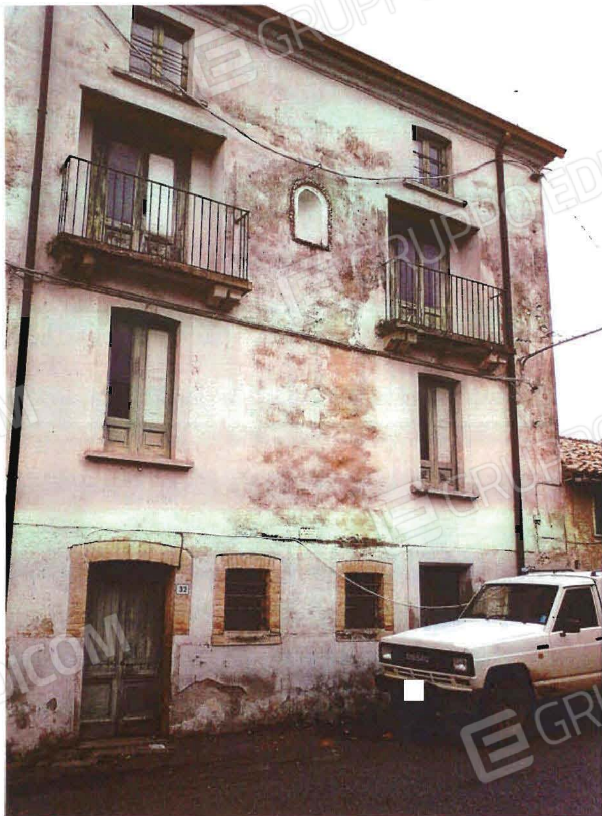
foto n°3_intero prospetto principale
