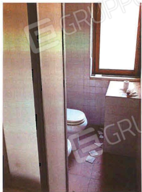
foto n°18_Particolari interno stanza n°4_PT
