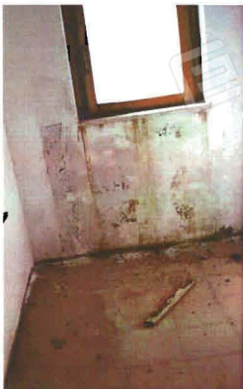
foto n°31 _Particolari ripostiglio 3P
