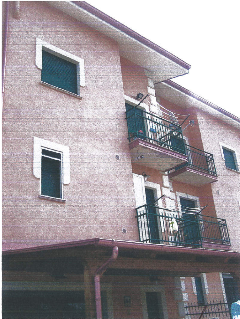
FACCIATA INGRESSO GARAGE
