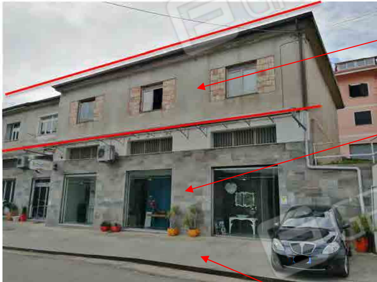
Foto n. 2 – veduta facciata principale fabbricato “particelle n.528 e 692” lato nord - ingresso da Via Nazionale -
