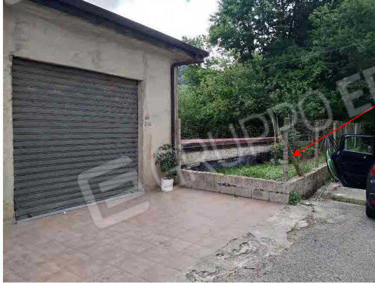
Foto n. 3 – veduta “giardinetto” a monte del fabbricato particella n.692.
