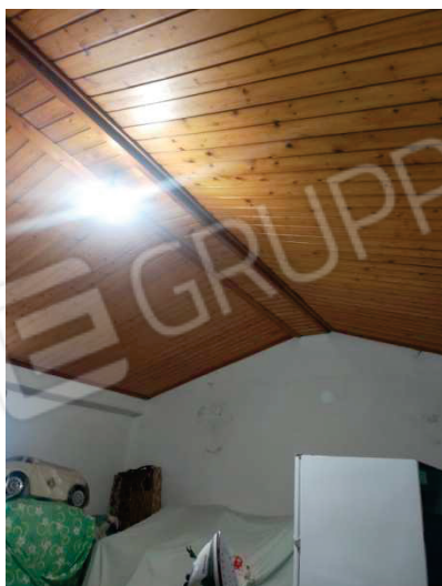
(Foto n.8_ vano piano secondo)
