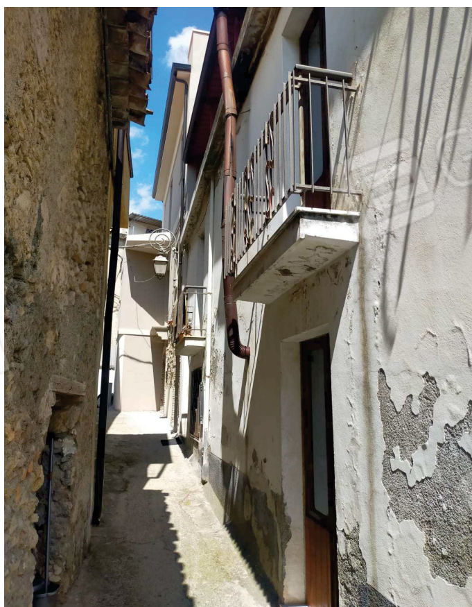
(Foto n.2_Immobile vista lato sud-ovest)
