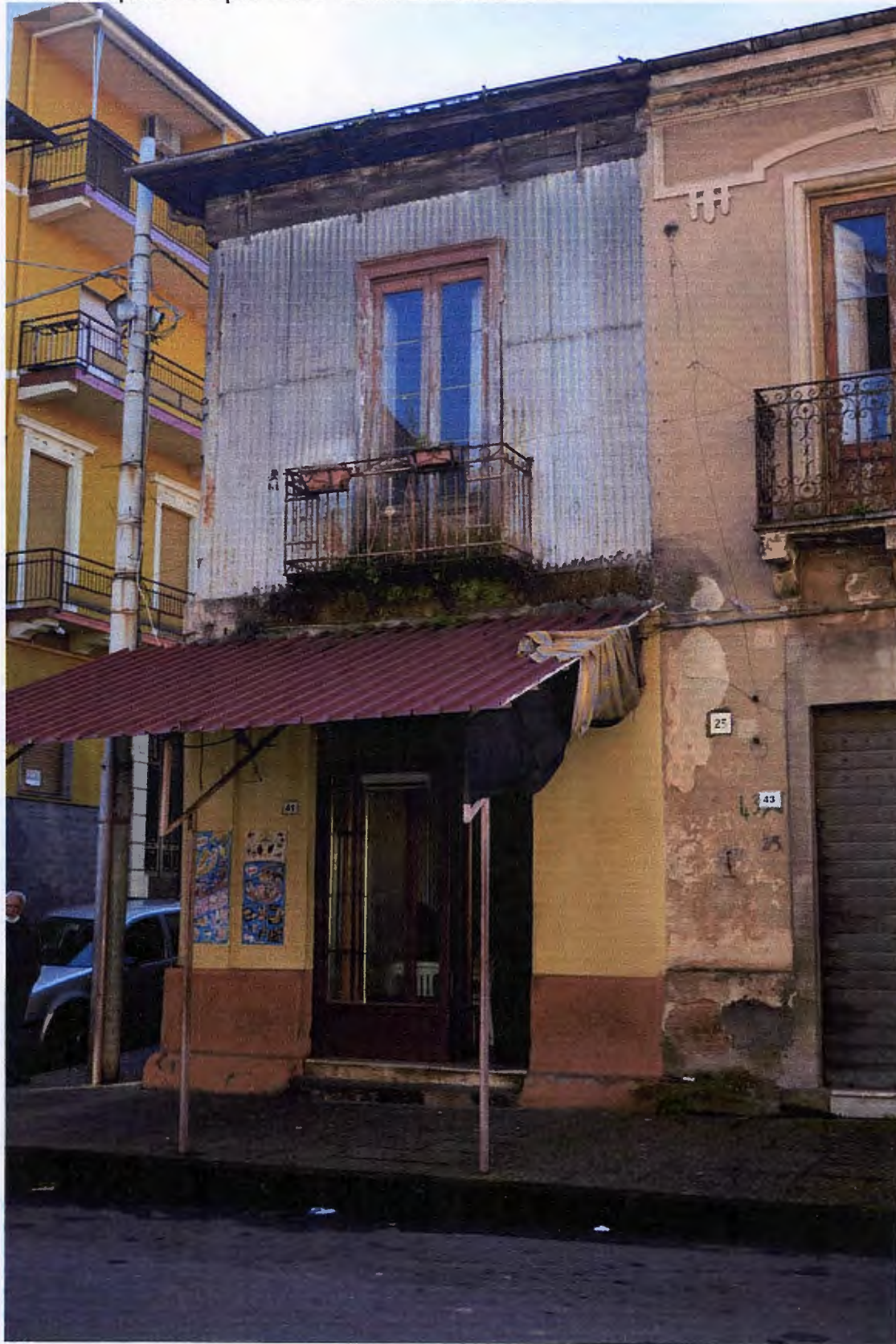
Foto 3: Prospetto Principale Corso Vittorio Emanuele n.c. 41
