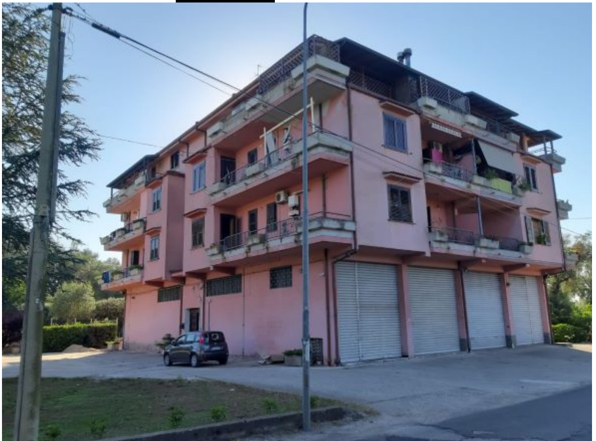
FOTO n.4 - Il fabbricato visto nel suo insieme
