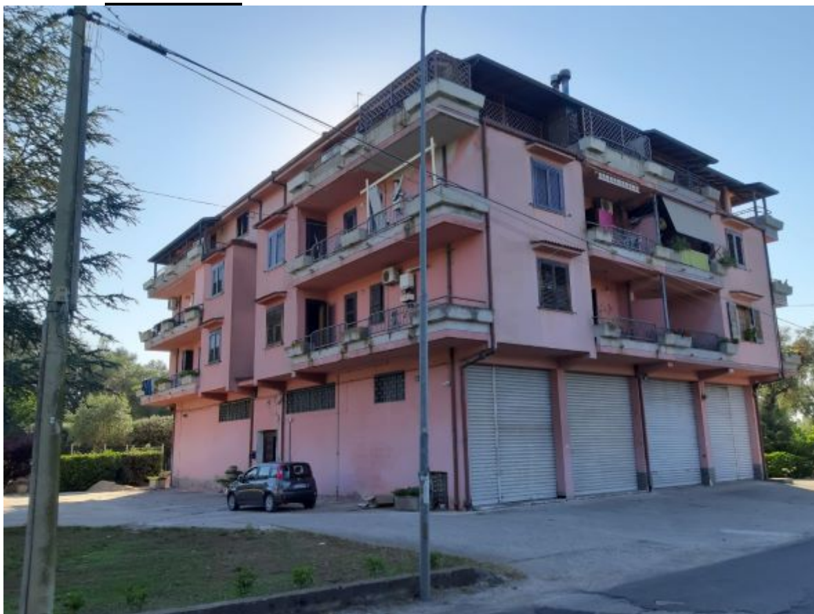
FOTO n. 4 Vista del fabbricato nel suo insieme
