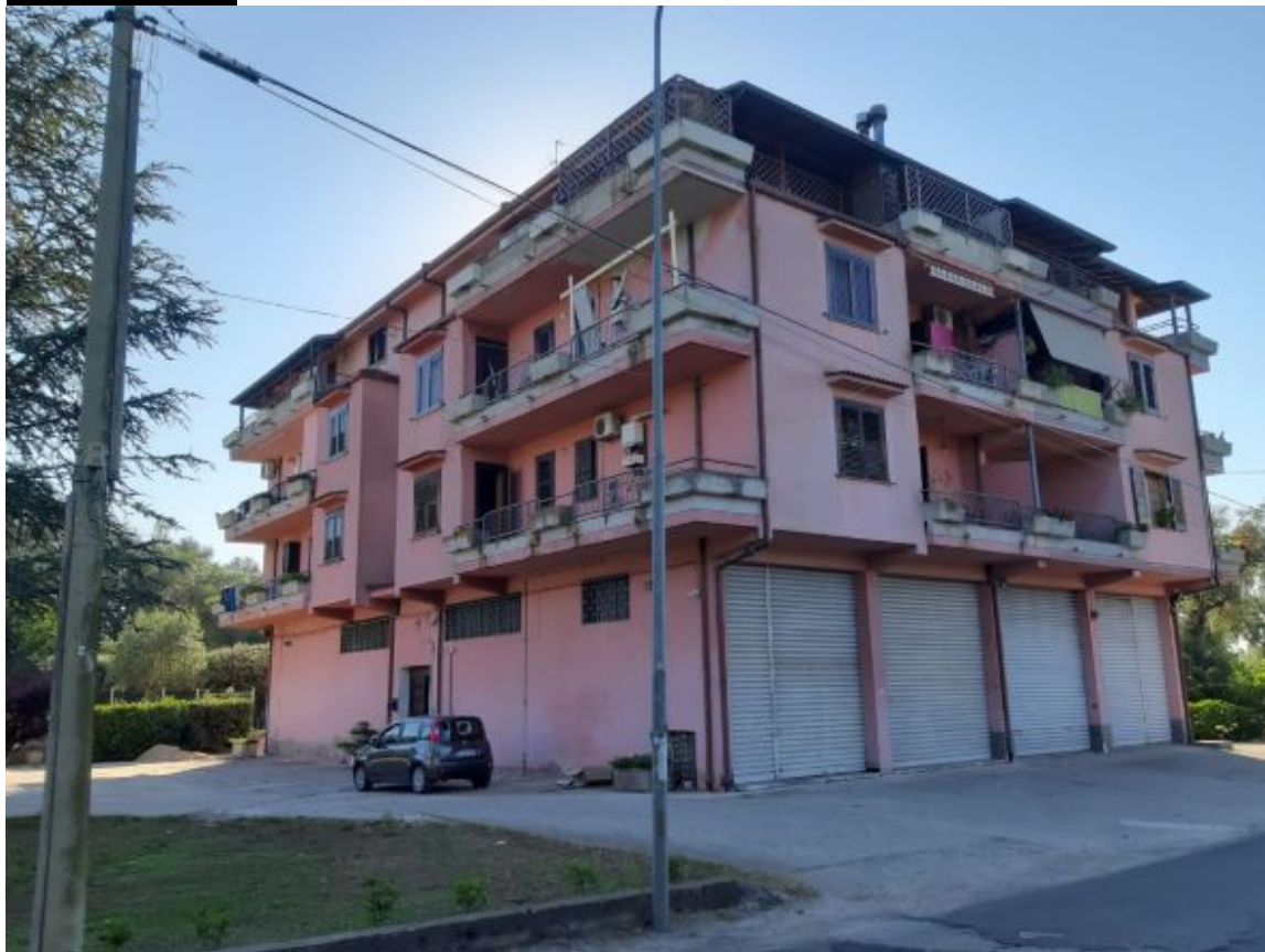
FOTO n. 4 Il Fabbricato visto nel suo insieme
