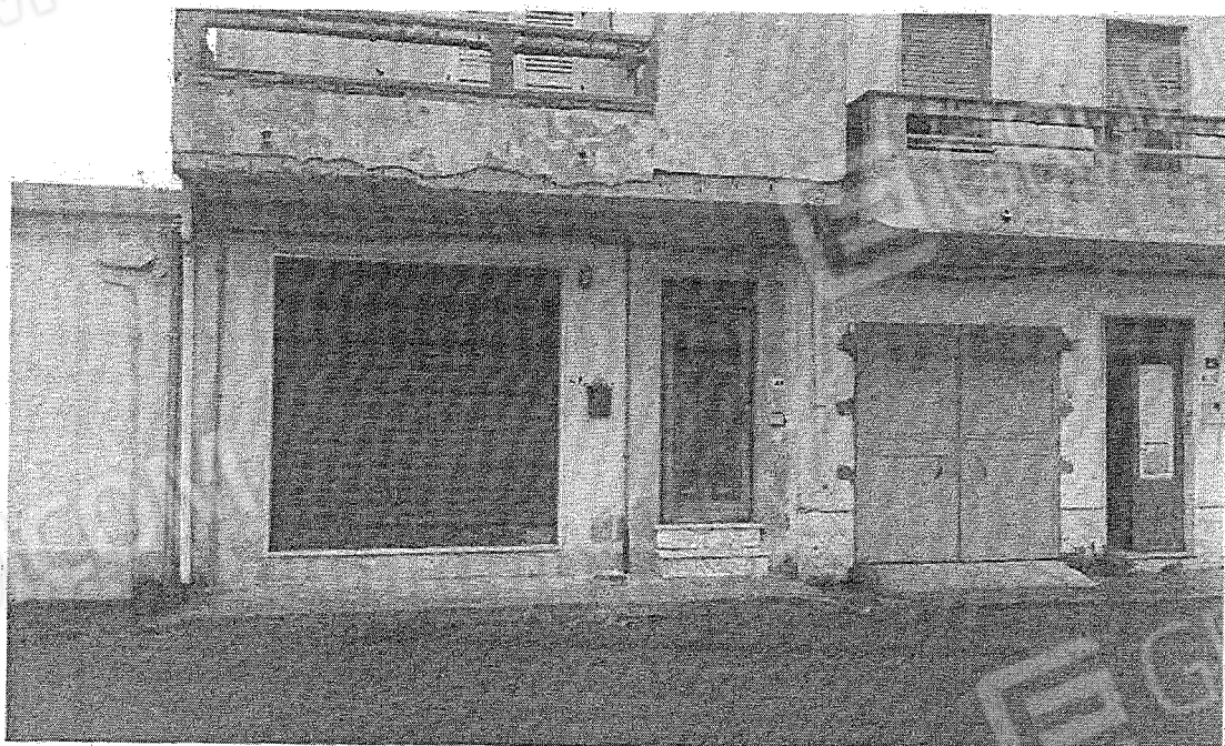
Foto 2: Comune di San Ferdinando foglio 13 particelle 719 subalterno 6 - Facciata principale.
