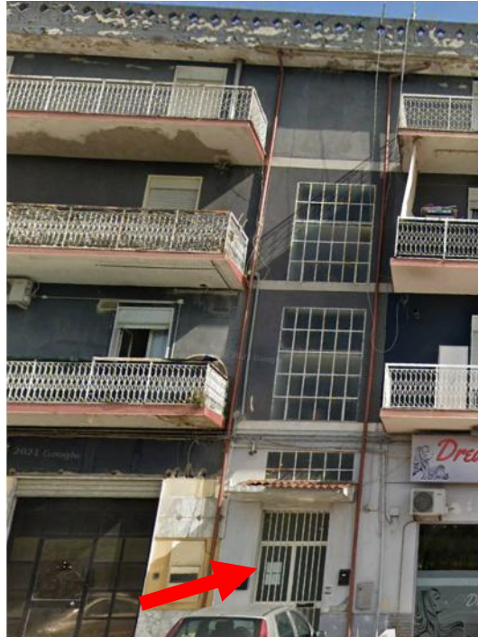
LOTTO 003 – Ingresso scala comune
