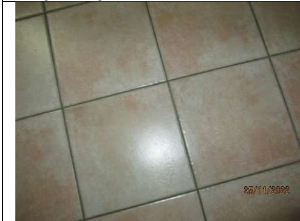
Foto 34. Particolare della tipologia di pavimentazione in cotto, presente nell'immobile
