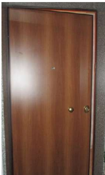
Foto 27. Vista del portone d'ingresso
