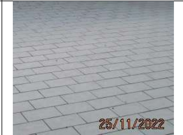
Foto 35. Particolare della tipologia di pavimentazione, presente all'esterno, sui balconi
